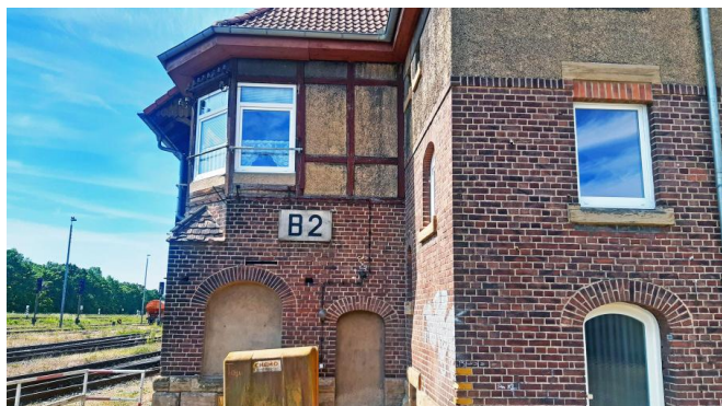
Wir ersetzen die veraltete Stellwerkstechnik am Bahnhof Zeitz durch Elektronische Stellwerkstechnik (Juli 2023) [Quelle: DB Netz AG/Clemens Haffner]
