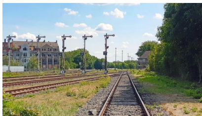
Blick vom Bahnhof Zeitz in Richtung Leipzig (Juli 2023) [Quelle: DB Netz AG/Clemens Haffner]
