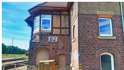
Wir ersetzen die veraltete Stellwerktechnik am Bahnhof Zeitz durch Elektronische Stellwerktechnik (Juli 2023) [Quelle: DB Netz AG/Clemens Haffner]
