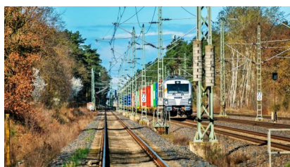
Im Rahmen des Projekts schaffen wir Überholmöglichkeiten für 740 Meter lange Güterzüge (März 2023) [Quelle: DB Netz AG/Jörn Daberkow]
