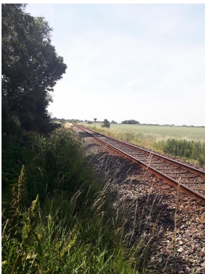
2020 werden auf der Strecke zwischen Ihrhove und der niederländischen Grenze in größeren räumlichen Abständen Untersuchungen des Baugrunds vorgenommen [Quelle: DB Netz AG/Isabel Ziebart]
