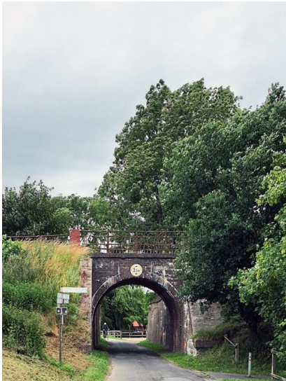
In den letzten Monaten wurden mehrere Brücken entlang der Strecke zwischen Ihrhove und der deutsch-niederländischen Grenze auf ihren Zustand untersucht. Zu den begutachteten Bauwerken zählt unter anderem auch die hier abgebildete Eisenbahnüberführung (EÜ) „Müggenborg“ (Juni 2020) [Quelle: DB Netz AG/Stefan Wey]
