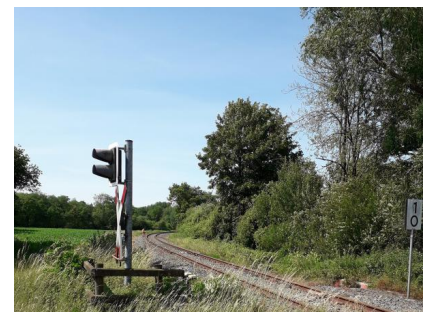
Die Strecke zwischen der niederländischen Grenze und Ihrhove wird im Rahmen der Baustufe 1 modernisiert (Juli 2019) [Quelle: DB Netz AG/Isabel Ziebart]
