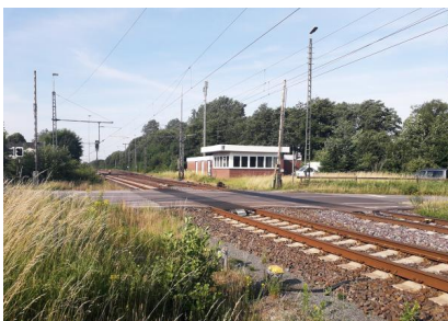
Blick auf das Stellwerk in Ihrhove (Juli 2019) [Quelle: DB Netz AG/Isabel Ziebart]
