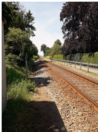
Bei den geplanten Baugrunduntersuchungen auf der Strecke zwischen Ihrhove und der niederländischen Grenze werden stichprobenartig Bodenproben entnommen, um die Beschaffenheit und Belastbarkeit des Untergrunds zu erfassen [Quelle: DB Netz AG/Isabel Ziebart]
