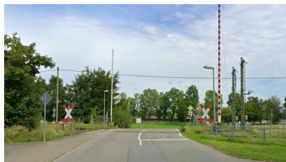
Bahnübergang zwischen Herbertingen und Aulendorf (September 2022) [Quelle: DB Netz AG/Christian Bedeschinski]
