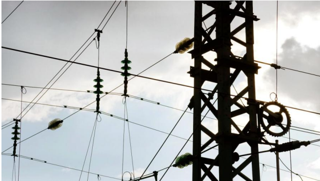
Der rund fünf Kilometer lange Abschnitt zwischen Wilhelmshaven Ölweiche und Wilhelmshaven Nord wird elektrifiziert. Dabei wird eine neue Oberleitungsanlage errichtet [Quelle: Symbolbild, Deutsche Bahn AG/Volker Emersleben]
