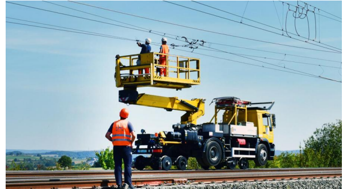
Der rund fünf Kilometer lange Abschnitt zwischen Wilhelmshaven Ölweiche und Wilhelmshaven Nord wird elektrifiziert [Quelle: Symbolbild, Deutsche Bahn AG/Markus Kehnen]
