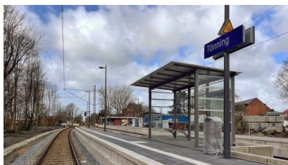
Blick auf den erneuerten Bahnhof Tönning (März 2024) [Quelle: DB InfraGO AG/Ruben Herrmann]
