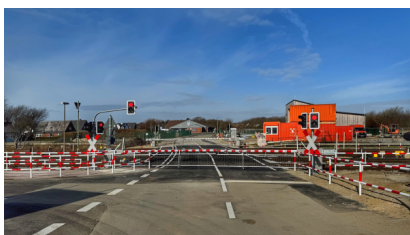
Der Bahnübergang „Königskamp“ im Ortsteil Tinnum der Gemeinde Sylt (März 2024) [Quelle: DB InfraGO AG/Sean Borchert]
