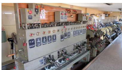
Das mechanische Stellwerk in Niebüll wird abgelöst (Oktober 2019) [Quelle: DB Netz AG]
