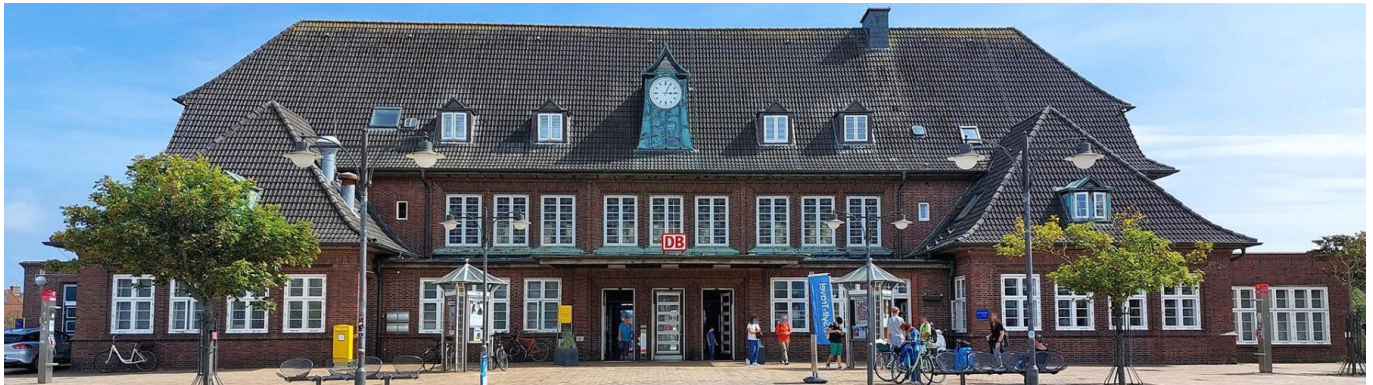
Das Projekt umfasst unter anderem die Sanierung des denkmalgeschützten Empfangsgebäudes (August 2022) [Quelle: DB InfraGO AG/Thilo Webermann]
