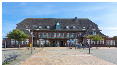
Das Projekt umfasst unter anderem die Sanierung des denkmalgeschützten Empfangsgebäudes (August 2022) [Quelle: DB InfraGO AG/Thilo Webermann]
