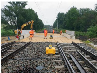
Die Planumsschutzschicht wird auf der neuen Bachbrücke zwischen Hopfgarten (Weimar) und Tröbsdorf eingebracht (August 2019) [Quelle: DB Netz AG]
