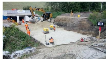
Der Boden unter der neuen Bachbrücke zwischen Hopfgarten (Weimar) und Tröbsdorf wird ausgetauscht (August 2019) [Quelle: DB Netz AG]
