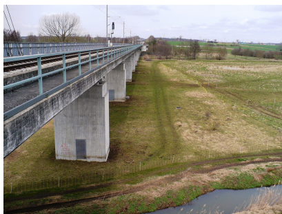
Die Schuntertalbrücke ist mit 250 Metern die längste Brücke der „Weddeler Schleife“. Sie ist derzeit für den eingleisigen Betrieb gebaut und wird im Rahmen des Projekts für die Zweigleisigkeit hergerichtet (März 2016) [Quelle: Deutsche Bahn AG/Jörg Tollkühn]
