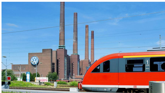
Um den Reiseverkehr flexibler zu gestalten und die Kapazitäten auf der Strecke zu steigern, wird der Abschnitt zwischen dem Abzweig Weddel und dem Bahnhof Fallersleben zweigleisig ausgebaut (Juli 2017) [Quelle: Clemens T. Kral]
