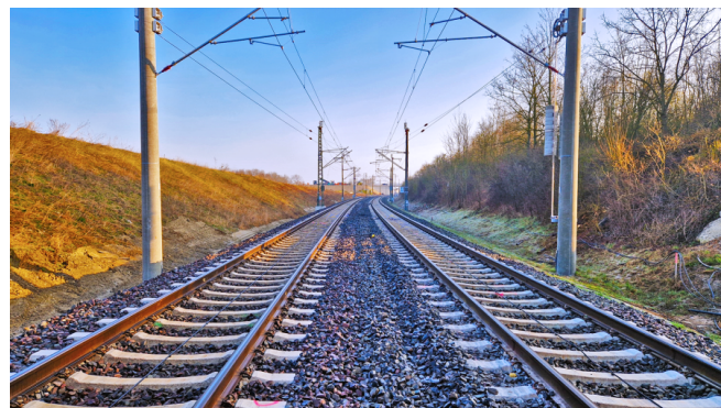
Blick auf die zweigleisige Strecke in Wolfsburg-Sülfeld (März 2024) [Quelle: DB InfraGO AG/Tobias Reiff]
