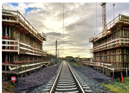
Während der Sperrpause für den Zugverkehr im November und Dezember 2022 sind die Arbeiten an der Straßenüberführung der Landesstraße L 292 in Wolfsburg-Sülfeld vorangeschritten (November 2022) [Quelle: DB Netz AG]
