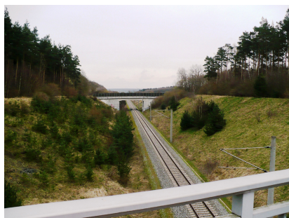
In vielen Abschnitten der „Weddeler Schleife“ sind während des Baus Mitte der 1990er Jahre bereits alle Vorkehrungen für den zweigleisigen Ausbau getroffen worden: Zahlreiche Brücken und Bahndämme sind breit genug für das zweite Gleis (März 2016) [Quelle: Deutsche Bahn AG/Jörg Tollkühn]
