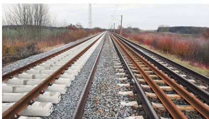
In der ersten Sperrpause für den Zugverkehr vom 29. Oktober bis 11. Dezember 2021 begannen die Hauptbauarbeiten für den zweigleisigen Ausbau der Strecke. Unter anderem wurde im Bereich Hordorf teilweise das zweite Gleis verlegt (Dezember 2021) [Quelle: DB Netz AG/Tobias Reiff]
