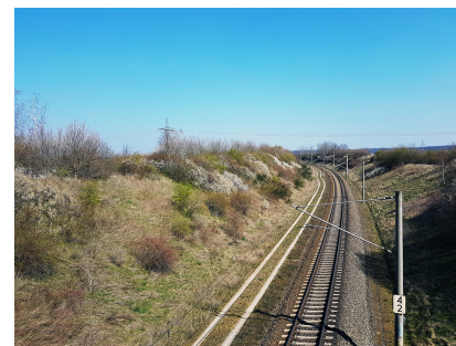
Ruhig scheint es derzeit an der Weddeler Schleife zuzugehen. Doch in dieser Hinsicht trägt der (Sonnenschein): Denn im Hintergrund laufen momentan zahlreiche Planungen und Ausschreibungsvorbereitungen für den zweigleisigen Ausbau der Bahnstrecke auf Hochtouren (April 2020) [Quelle: DB Netz AG/Hanna Megas]
