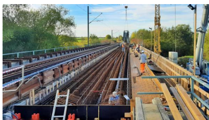
Während der Sperrpause für den Zugverkehr im November und Dezember 2022 wurde unter anderem im Überbau der Eisenbahnüberführung „Sandbach“ die Hüllrohrverlegung für die Spannglieder durchgeführt (November 2022) [Quelle: DB Netz AG]
