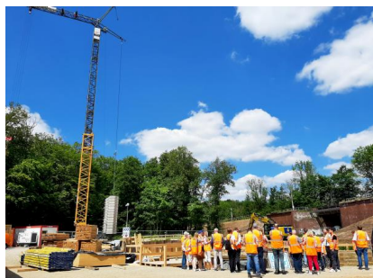
Am 16. Juni 2022 haben circa 25 Vertretende der Politik und der Verwaltung des Regionalverbands Großraum Braunschweig die Baustelle in Klein Brunsrode besichtigt (Juni 2022) [Quelle: DB Netz AG/Lara-Tanita Rust]
