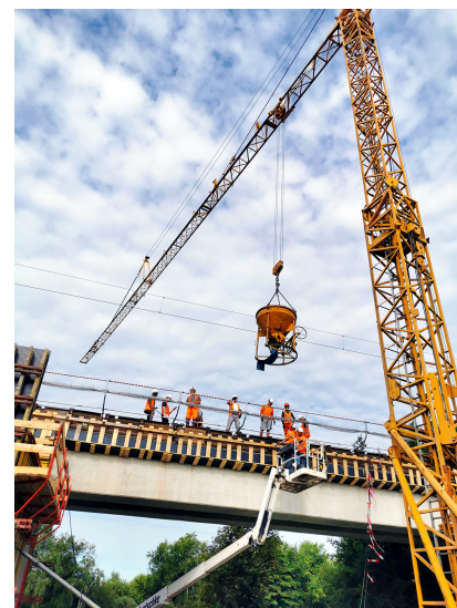
Die neue Eisenbahnbrücke über die Kreisstraße K 37 wurde während der Sperrpause für den Zugverkehr im November und Dezember 2022 eingeschoben (November 2022) [Quelle: DB Netz AG]
