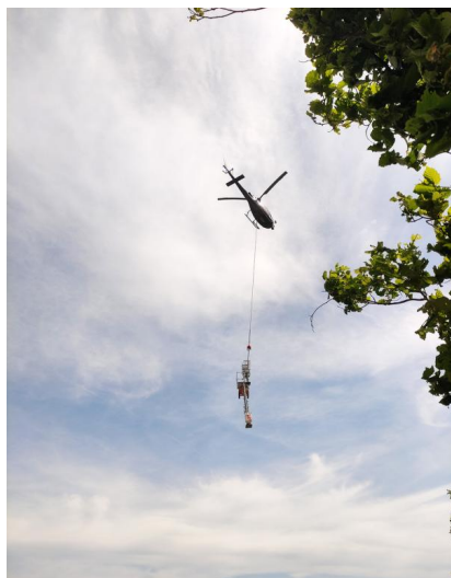
Während der Sperrpause für den Zugverkehr vom 13. bis 20. Mai 2022 haben wir unter anderem neue Signale mit einem Helikopter aufgestellt. Die Signale wurden an drei Sammelpunkten am Boden vorbereitet und dort durch den Helikopter aufgenommen (Mai 2022) [Quelle: DB Netz AG/Lara-Tanita Rust]
