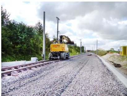
Im Streckenabschnitt neben der Landesstraße L 292 finden während der fünften Sperrpause für den Zugverkehr Bauarbeiten statt (August 2023) [Quelle: DB Netz AG]
