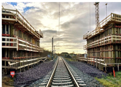
Während der Sperrpause für den Zugverkehr im November und Dezember 2022 sind die Arbeiten an der Straßenüberführung der Landesstraße L 292 in Wolfsburg-Sülfeld vorangeschritten (November 2022) [Quelle: DB Netz AG]
