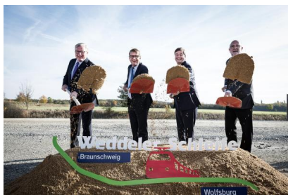
Am 25. Oktober 2021 fand der offizielle Spatenstich für den zweigleisigen Ausbau der Weddeler Schleife statt. Dr. Bernd Althusmann (Niedersächsischer Minister für Wirtschaft, Arbeit, Verkehr und Digitalisierung), Ronald Pofalla (Infrastrukturvorstand der Deutschen Bahn), Enak Ferlemann (Parlamentarischer Staatssekretär beim Bundesminister für Verkehr und digitale Infrastruktur) und Detlef Tanke (Verbandsvorsitzender vom Regionalverband Großraum Braunschweig) (v. l. n. r.) gaben das Startsignal für den Ausbau [Quelle: Deutsche Bahn AG/Anastasia Schuster]
