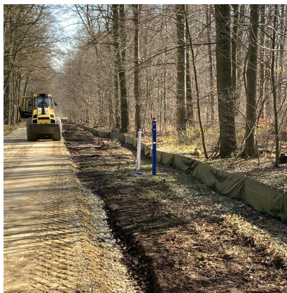
In Zusammenarbeit mit Ommo Ommen und der Ortsgruppe Lehre des Förderkreises Umwelt und Naturschutz Hondelage e.V. (FUN) wurde an der Zufahrtsstraße zur Kreisstraße K 37 ein Amphibienschutzzaun erstellt (März 2022) [Quelle: DB Netz AG/Katrin Huhs]
