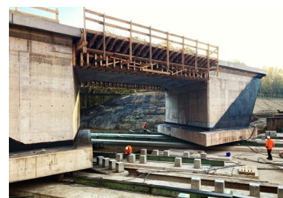
Die neue Eisenbahnbrücke über die Kreisstraße K 37 wurde während der Sperrpause für den Zugverkehr im November und Dezember 2022 eingeschoben (November 2022) [Quelle: DB Netz AG]
