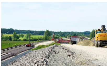
Innerhalb der Sperrpause für den Zugverkehr vom 13. bis 20. Mai 2022 haben wir beispielsweise Gründungs- bzw. Rammarbeiten durchgeführt sowie Arbeiten an der Oberleitung und am Oberbau vorgenommen (Mai 2022) [Quelle: Deutsche Bahn AG/Andreas Sahlmann]
