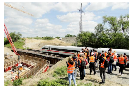
Während einer Baustellenbesichtigung für Studierende der Technischen Universität Braunschweig hat unter anderem ein Halt in Wolfsburg-Sülfeld an der Straßenüberführung der Landstraße L 321 stattgefunden. Hier wurde zu diesem Zeitpunkt das Fundament für das westliche Widerlager betoniert (Juni 2022) [Quelle: Technische Universität Braunschweig/Dr.-Ing. Gunnar Bosse]
