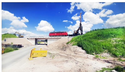
Im Juli 2023 haben wir während der fünften Sperrpause für den Zugverkehr im Bereich Klein Brunstode Rammpfahlgründungen durchgeführt (Juli 2023) [Quelle: DB Netz AG]
