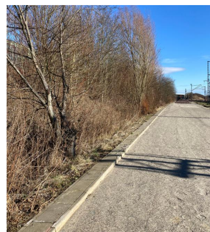
Außerhalb der Totalsperrungen werden Arbeiten zur Herstellung des Kabeltiefbaus sowie weitere bauvorbereitende Arbeiten durchgeführt, so wie hier im Bereich Weddel (Februar 2022) [Quelle: DB Netz AG/Katrin Huhs]
