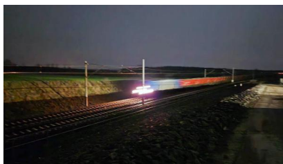
Der erste Zug fährt nach der Inbetriebnahme am 21. März 2024 um 22 Uhr über die nun zweigleisige Strecke (März 2024) [Quelle: DB InfraGO AG/Tobias Reiff]
