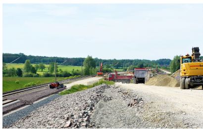
Innerhalb der Sperrpause für den Zugverkehr vom 13. bis 20. Mai 2022 haben wir beispielsweise Gründungs- bzw. Rammarbeiten durchgeführt sowie Arbeiten an der Oberleitung und am Oberbau vorgenommen (Mai 2022) [Quelle: Deutsche Bahn AG/Andreas Sahlmann]
