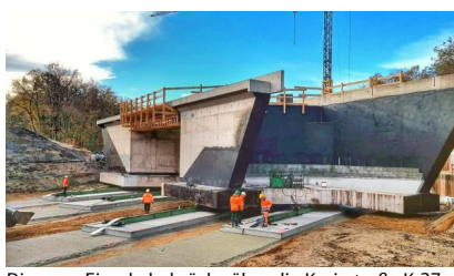
Die neue Eisenbahnbrücke über die Kreisstraße K 37 wurde während der Sperrpause für den Zugverkehr im November und Dezember 2022 eingeschoben (November 2022) [Quelle: DB Netz AG]
