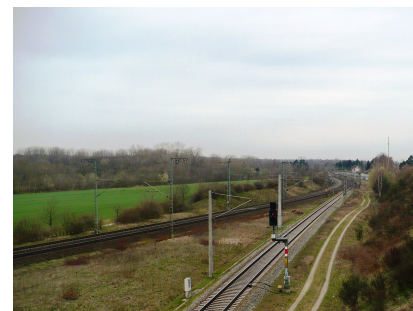
Kurz hinter Weddel zweigt die „Weddeler Schleife“ in Richtung Fallersleben von der Strecke Braunschweig – Magdeburg ab (März 2016) [Quelle: Deutsche Bahn AG/Jörg Tollkühn]
