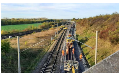
Während der vierten Sperrpause für den Zugverkehr im November und Dezember 2022 wurden unter anderem Arbeiten an den Weichen und Gleisen sowie Kabeltiefbau-, Brücken- und Rammarbeiten durchgeführt (November 2022) [Quelle: DB Netz AG]
