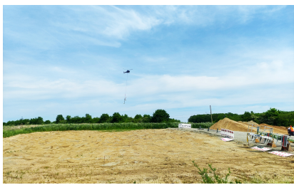
Während der Sperrpause für den Zugverkehr vom 13. bis 20. Mai 2022 haben wir unter anderem neue Signale mit einem Helikopter aufgestellt. Der Helikopter hat insgesamt 33 Signale auf einem Streckenabschnitt von circa 15 Kilometern eingeflogen (Mai 2022) [Quelle: DB Netz AG/Lara-Tanita Rust]
