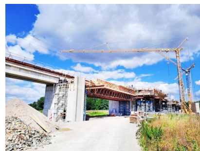
Blick auf die Bauarbeiten an der Eisenbahnüberführung „Schunter“ während der fünften Sperrpause für den Zugverkehr (August 2023) [Quelle: DB Netz AG]
