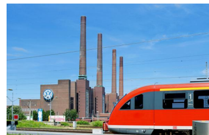
Um den Reiseverkehr flexibler zu gestalten und die Kapazitäten auf der Strecke zu steigern, wird der Abschnitt zwischen dem Abzweig Weddel und dem Bahnhof Fallersleben zweigleisig ausgebaut (Juli 2017) [Quelle: Clemens T. Kral]
