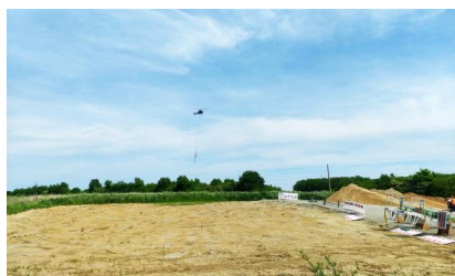
Während der Sperrpause für den Zugverkehr vom 13. bis 20. Mai 2022 haben wir unter anderem neue Signale mit einem Helikopter aufgestellt. Der Helikopter hat insgesamt 33 Signale auf einem Streckenabschnitt von circa 15 Kilometern eingeflogen (Mai 2022) [Quelle: DB Netz AG/Lara-Tanita Rust]
