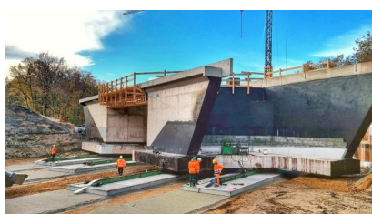
Die neue Eisenbahnbrücke über die Kreisstraße K 37 wurde während der Sperrpause für den Zugverkehr im November und Dezember 2022 eingeschoben (November 2022) [Quelle: DB Netz AG]
