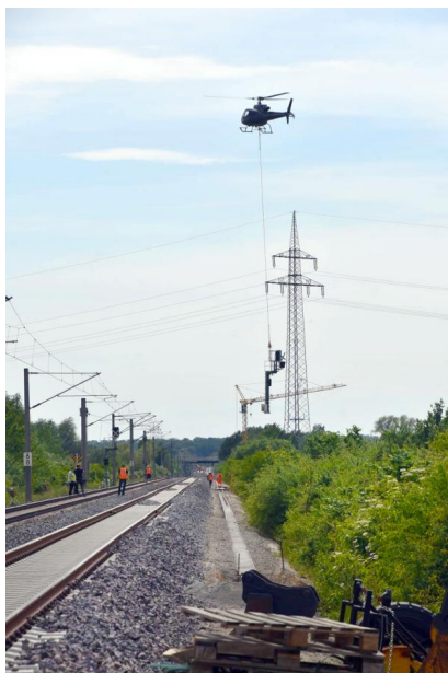
Während der Sperrpause für den Zugverkehr vom 13. bis 20. Mai 2022 haben wir unter anderem neue Signale mit einem Helikopter aufgestellt. Die Signale wurden nach und nach mit einem Helikopter an ihren Standort gebracht (Mai 2022) [Quelle: Deutsche Bahn AG/Andreas Sahlmann]
