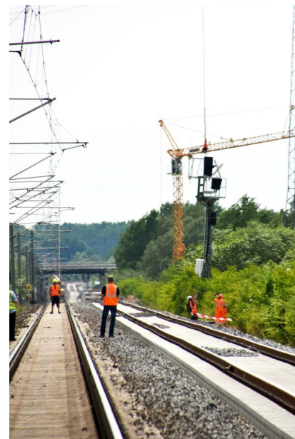
Während der Sperrpause für den Zugverkehr vom 13. bis 20. Mai 2022 haben wir unter anderem neue Signale mit einem Helikopter aufgestellt. Beim Einfliegen der Signale waren Bodenteams im Einsatz, die die Signale in Empfang genommen und befestigt haben (Mai 2022) [Quelle: Deutsche Bahn AG/Andreas Sahlmann]
