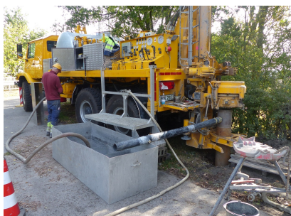
Derzeit finden zwischen Weddel und Fallersleben Baugrunduntersuchungen statt. Mit dieser Bohrmaschine können alle in der Baugrunduntersuchung anfallenden Bohrarten (Drehen, Schlagen, Bohren) durchgeführt werden. Das Hauptaugenmerk der Bohrungen liegt auf dem Gewinn von durchgängigen Bodenproben (sogenannte Bohrkerne) (September 2018) [Quelle: DB Netz AG/Maxim Faber]
