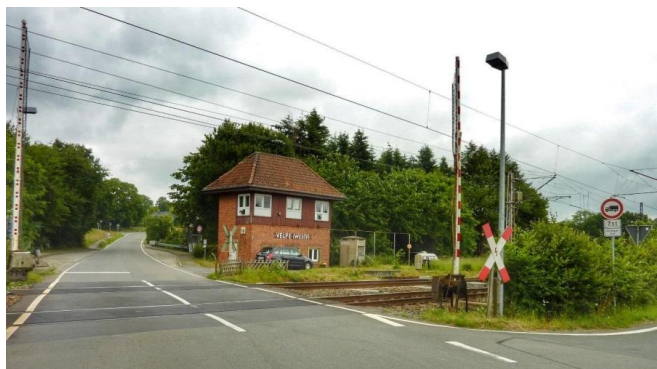
Der alte Bahnübergang „Tecklenburger Straße“ wird zu einem Trogbauwerk umgebaut (Juni 2015) [Quelle: DB Netz AG]
