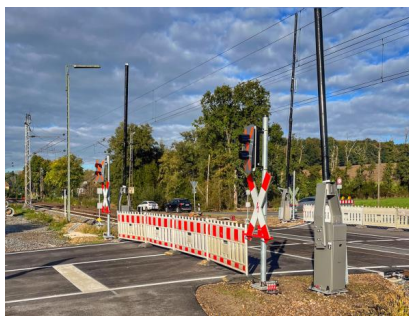
Der Bahnübergang „Gattenweg“ kurz vor der Inbetriebnahme (Oktober 2024) [Quelle: DB InfraGO AG]
