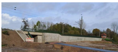
Blick auf die neue Eisenbahnüberführung „Markenweg“ inklusive Stützwand (November 2023) [Quelle: DB Netz AG]
