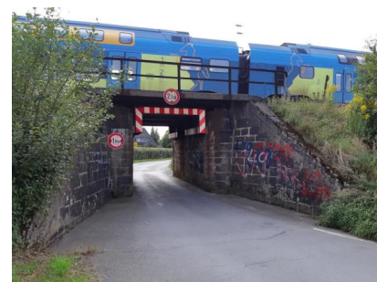
Die alte Eisenbahnüberführung „Markenweg“ (September 2021) [Quelle: DB Netz AG]
