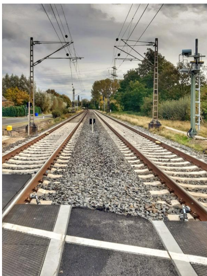
Blick auf den Bahnübergang „Gattenweg“ (Oktober 2024) [Quelle: DB InfraGO AG]
