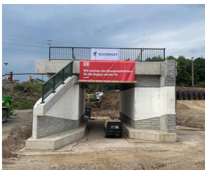
Die neue Eisenbahnüberführung „Markenweg“ vor dem Vershub (Juni 2023) [Quelle: DB Netz AG]
