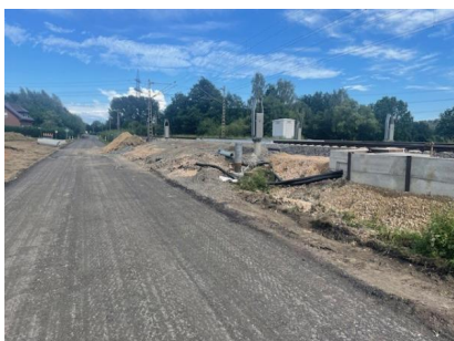
Der Bauzustand an der Velper Straße mit Blick auf den Übergang zum neuen Bahnübergang „Gattenweg“ (Juli 2024) [Quelle: DB InfraGO AG]
