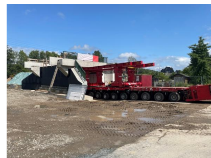
Blick auf den Vershub der Eisenbahnüberführung „Markenweg“ (September 2023) [Quelle: DB Netz AG]
