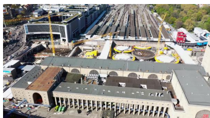
YouTube: Alessa auf der Baustelle – Bonatzbau [Quelle: Deutsche Bahn AG]
