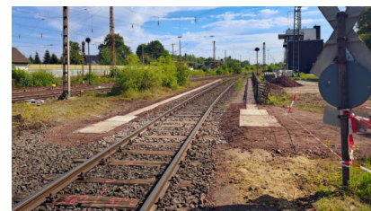
Wir führen unter anderem Kabeltiefbauarbeiten durch (Mai 2025) [Quelle: DB InfraGO AG]
