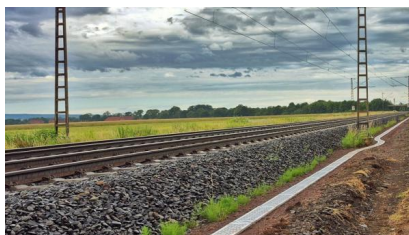
Blick auf einen bereits fertiggestellten Kunststoffkabelkanal (Juni 2025) [Quelle: DB InfraGO AG]
