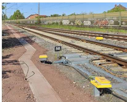
Blick auf einen bereits fertiggestellten Betonkabelkanal (Mai 2025) [Quelle: DB InfraGO AG]
