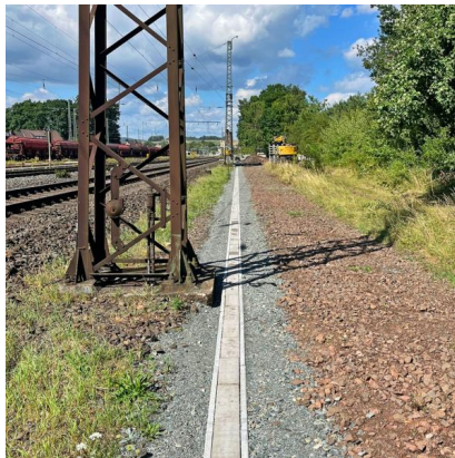
Neue Kanäle führen Kabel entlang der Bahnstrecke (August 2025) [Quelle: DB InfraGO AG]
