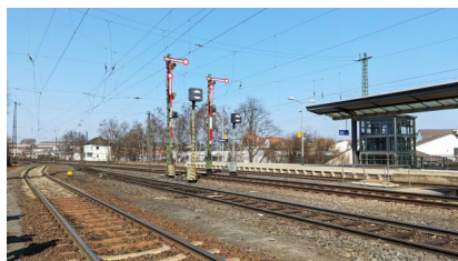
Blick auf die bestehende Signal- und Stellwerkstechnik im Bahnhof Stadtallendorf (März 2022) [Quelle: ISB Ingenieurgesellschaft für Sicherungstechnik und Bau mbH/Carsten Braune]
