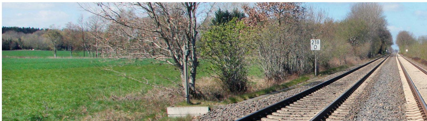
Blick auf einen Abschnitt der 62 Kilometer langen Strecke. Dieser wird elektrifiziert (April 2021) [Quelle: DB Netz AG/Cornelia Granofsky]
