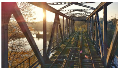
Die Brücke bei der Charlottenburger Schleuse zum Spandauer Ufer muss komplett neu gebaut werden. Die alte Brücke wurde im Rahmen des Ausbaus der Spreeschleuse 1997 zurückgebaut. Derzeit untersuchen wir, welche Brückenart dafür infrage kommt. Möglich wären zum Beispiel eine Stabbogenbrücke oder eine Fachwerkbrücke (November 2021) [Quelle: Deutsche Bahn AG/Sebastian Elm]
