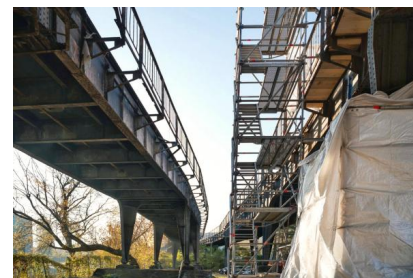
Entlang der Gleise wird eine Einhausung hergestellt. Diese ist für den Auftrag der Musterflächen notwendig, anhand derer die Festlegung zum zukünftigen Korrosionsschutz getroffen wird (November 2021) [Quelle: Deutsche Bahn AG/Sebastian Elm]
