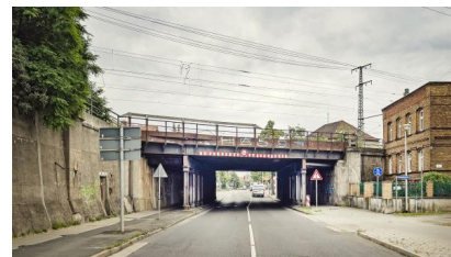
Wir erneuern die Eisenbahnbrücke und senken die darunter verlaufende Straße ab (Juni 2021) [Quelle: DB Netz AG/Jörn Daberkow]
