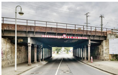
Wir erneuern die Eisenbahnbrücke und senken die darunter verlaufende Straße ab (Juni 2021) [Quelle: DB Netz AG/Jörn Daberkow]
