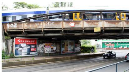
Die Straße wird unter der neuen Brücke um circa 2,5 Meter abgesenkt (August 2018) [Quelle: DB Netz AG]
