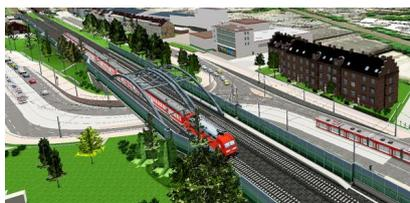
Visualisierung: Blick auf die neue Eisenbahnüberführung „Sebaldsbrücker Heerstraße“. Das Brückenbauwerk wird verbreitert und mit zusätzlichem Schallschutz ausgestattet (Juni 2021) [Quelle: DB Engineering & Consulting GmbH]
