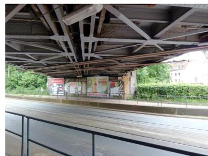
Die Eisenbahnüberführung hat das Ende ihrer technischen Nutzungsdauer erreicht und muss ersetzt werden (August 2018) [Quelle: DB Netz AG]
