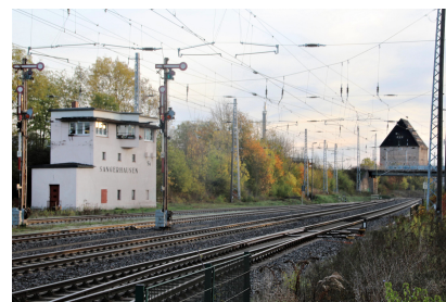
Am Bahnhof Sangerhausen müssen unter anderem Weichen versetzt werden (Oktober 2019) [Quelle: Deutsche Bahn AG/PLUS Ingenieurdienste GmbH]
