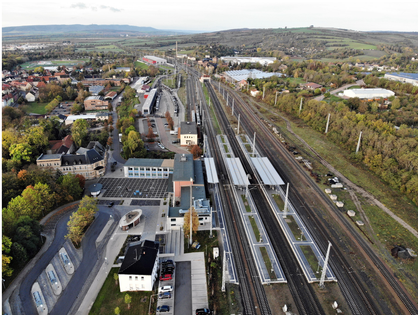
Blick auf den Bahnhof Sangerhausen vor den Bauarbeiten (Oktober 2019) [Quelle: DB Netz AG]
