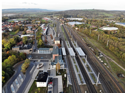
Blick auf den Bahnhof Sangerhausen vor den Bauarbeiten (Oktober 2019) [Quelle: Deutsche Bahn AG/PLUS Ingenieurdienste GmbH]
