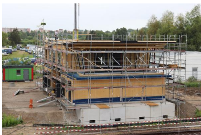
Außenansicht des neuen Elektronischen Stellwerks während der Bauarbeiten (Juli 2024) [Quelle: DB InfraGO AG]
