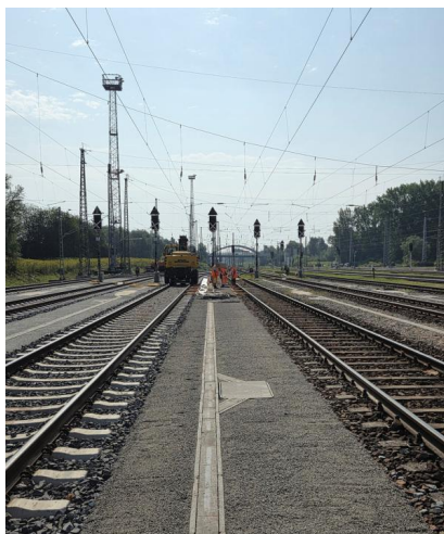
Blick auf die neuen Kabelkanäle für die Bahntechnik (August 2025) [Quelle: DB InfraGO AG]
