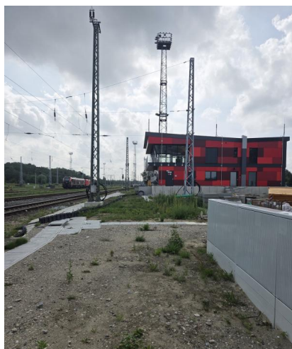
Blick auf das neue Elektronische Stellwerk mit farbiger Außenbeplankung (Juli 2025) [Quelle: DB InfraGO AG]
