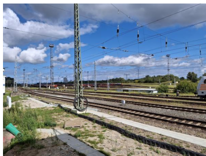
Blick in Richtung des Seehafens (August 2025) [Quelle: DB InfraGO AG]
