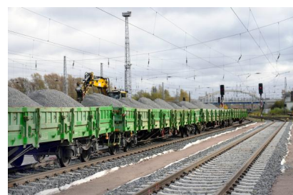
Für die Bauarbeiten wurde in Güterzügen viel Material angeliefert (November 2023) [Quelle: DB Netz AG]
