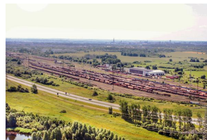
Blick auf den Rangierbahnhof des Rostocker Seehafens aus der Vogelperspektive (Juli 2013) [Quelle: DB Netz AG/Frank Haberlandt]
