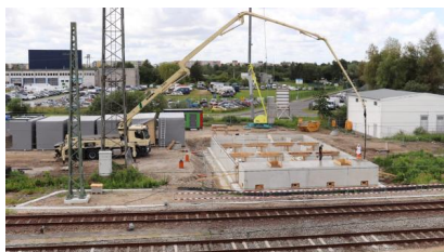
Beginn der Bauarbeiten für das neue Elektronische Stellwerk (Mai 2024) [Quelle: DB InfraGO AG]
