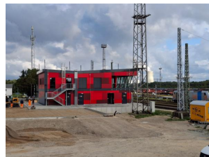
Blick auf das neue Elektronische Stellwerk mit farbiger Außenbeplankung (August 2025) [Quelle: DB InfraGO AG]
