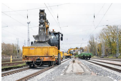
Im Rahmen der Bauphase 1.1 erneuern wir unter anderem Teile des Oberbaus (November 2023) [Quelle: DB Netz AG]
