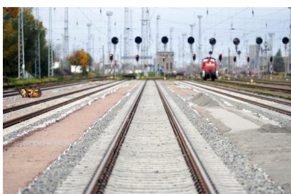
Blick auf die erneuerten Gleise (November 2023) [Quelle: DB Netz AG]
