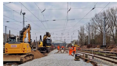
Im Rahmen der Bauphase 1.1 führen wir Arbeiten am Oberbau durch (März 2024) [Quelle: DB InfraGO AG]
