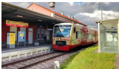
Der Bahnhof Schwenningen (Neckar) wird im Rahmen des Projekts ausgebaut (April 2023) [Quelle: DB Netz AG/Michaela Streicher]
