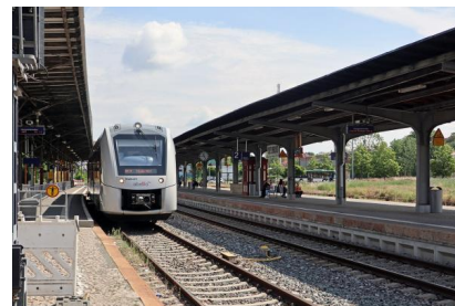
Blick auf die Bahnsteige 1 (links) sowie 2/3 (rechts) im Bahnhof Quedlinburg (Juni 2020) [Quelle: DB Station&Service AG]
