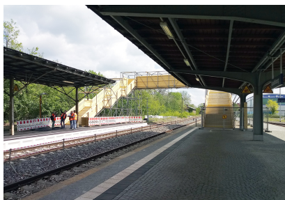
Um die Erreichbarkeit des Bahnsteigs 2/3 während der Bauarbeiten zu ermöglichen, wurde eine provisorische Fußgängerbrücke errichtet (Mai 2020) [Quelle: DB Station&Service AG]
