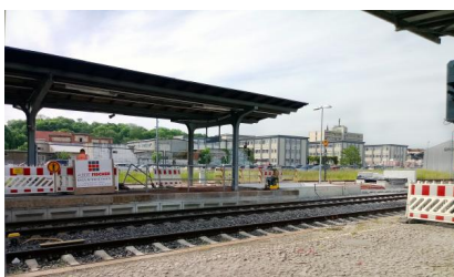
Blick auf den Bahnsteig 2/3 des Bahnhofs Quedlinburg. Hier finden derzeit Vorbereitungen für den Einbau der Aufzüge und der Treppeneinhausung statt (Juni 2021) [Quelle: DB Station&Service AG]
