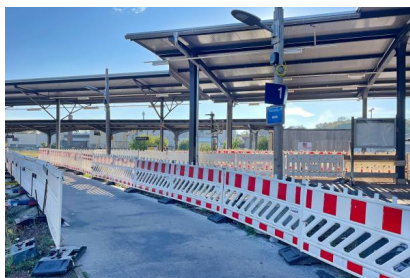
Die Zuwegung zum Bahnsteig 1 (Oktober 2024) [Quelle: DB InfraGO AG]
