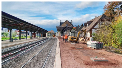
Blick auf den noch ungepflasterten Bahnsteig 1. Die Pflastersteine wurden bereits angeliefert [Quelle: DB Station&Service AG]
