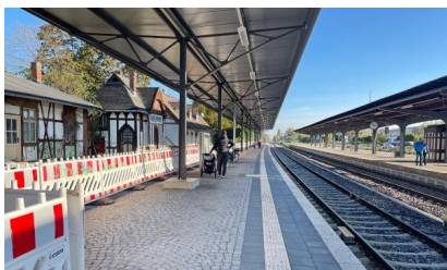
Blick auf den Bahnsteig 1 (Oktober 2024) [Quelle: DB InfraGO AG]
