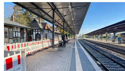
Blick auf den Bahnsteig 1 (Oktober 2024) [Quelle: DB InfraGO AG]
