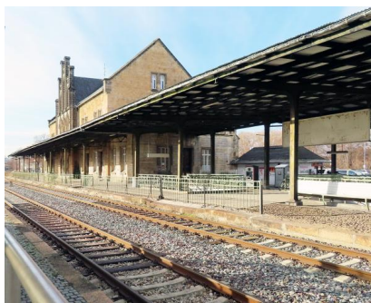
Blick auf den Bahnsteig 1 und das Empfangsgebäude des Bahnhofs Quedlinburg (Dezember 2019) [Quelle: DB Station&Service AG]
