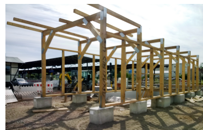
Die neue Treppeneinhausung am Bahnhof Quedlinburg wird gebaut (Juni 2021) [Quelle: DB Station&Service AG]
