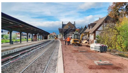
Blick auf den noch ungepflasterten Bahnsteig 1. Die Pflastersteine wurden bereits angeliefert [Quelle: DB Station&Service AG]
