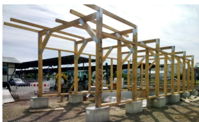
Die neue Treppeneinhausung am Bahnhof Quedlinburg wird gebaut (Juni 2021) [Quelle: DB Station&Service AG]
