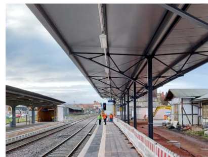
Der Bahnsteig 1 ist halbseitig gepflastert (November 2022) [Quelle: DB Station&Service AG]
