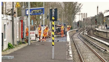
Derzeit wird im Bahnhof Pinneberg unter anderem der Bahnsteig am Gleis 1 erneuert (März 2021) [Quelle: DB Station&Service AG]
