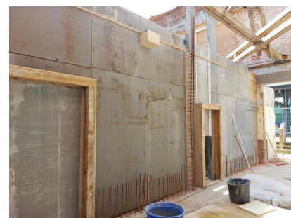
Wir sanieren das Empfangsgebäude (August 2024) [Quelle: DB InfraGO AG]
