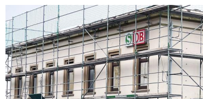
Das Empfangsgebäude am Bahnhof Pinneberg wird erneuert (März 2023) [Quelle: DB Station&Service AG]
