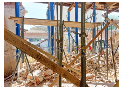
Das Empfangsgebäude wird komplett entkernt (August 2024) [Quelle: DB InfraGO AG]
