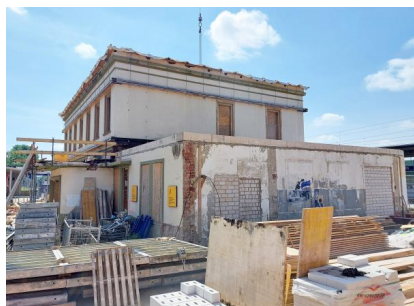
Blick auf den Baufortschritt am Empfangsgebäude (August 2024) [Quelle: DB InfraGO AG]
