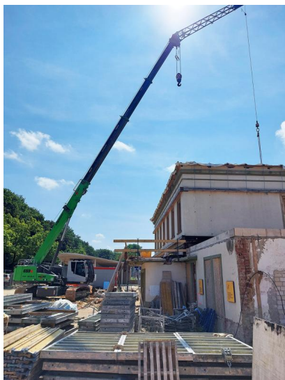
Blick auf den Baufortschritt am Empfangsgebäude (August 2024) [Quelle: DB InfraGO AG]
