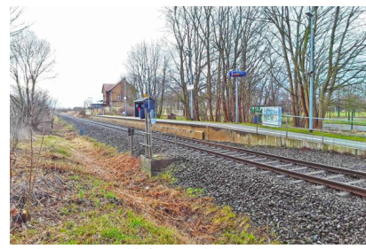
An der Station Vehlefanz wird der Bahnsteig um 95 Meter verlängert (März 2019) [Quelle: DB Station&Service AG]
