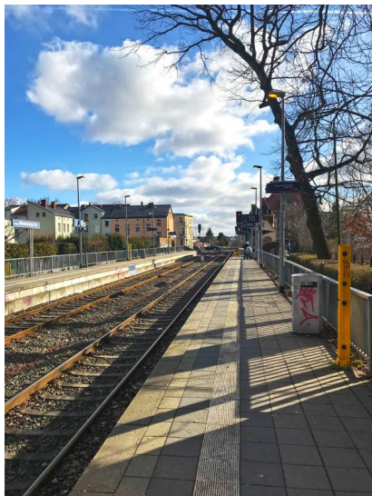
Blick auf die Bahnsteige am Bahnhof Neuruppin Rheinsberger Tor (Mai 2019) [Quelle: DB Station&Service AG]
