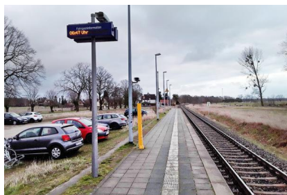
Der Bahnsteig an der Station Beetz-Sommerfeld vor den Arbeiten (März 2019) [Quelle: DB Station&Service AG]
