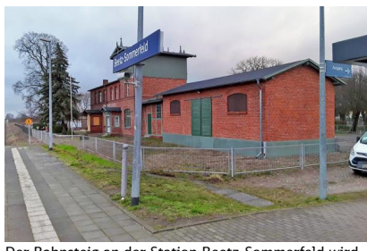
Der Bahnsteig an der Station Beetz-Sommerfeld wird auf 145 Meter verlängert (März 2019) [Quelle: DB Station&Service AG]
