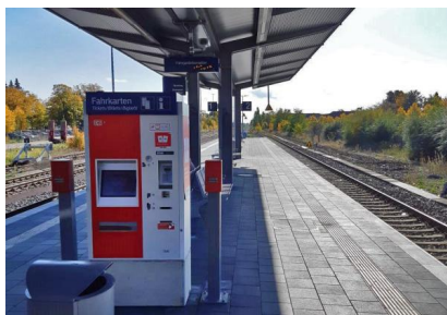
Der Mittelbahnsteig am Bahnhof Velten (Mark) wird um 45 Meter in Richtung Süden verlängert (Oktober 2019) [Quelle: DB Station&Service AG]
