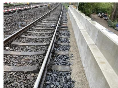
Das erste Element des neuen Außenbahnsteigs sind die Bahnsteigkanten, der Rest des Bahnsteigs folgt im Anschluss (April 2025) [Quelle: ai Consult GmbH]
