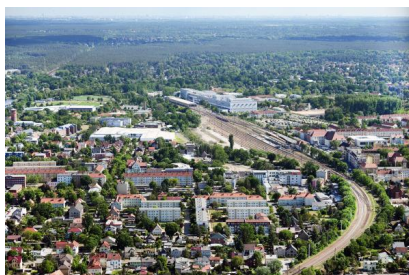
Wir modernisieren die Infrastruktur im Bahnhof Oranienburg und rüsten auf Elektronische Stellwerkstechnik um (Juni 2020) [Quelle: DB Netz AG]
