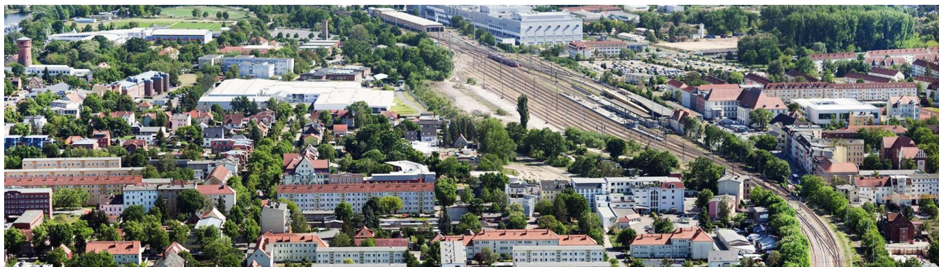
Wir modernisieren die Infrastruktur im Bahnhof Oranienburg und rüsten auf Elektronische Stellwerkstechnik um (Juni 2020) [Quelle: DB Netz AG]
