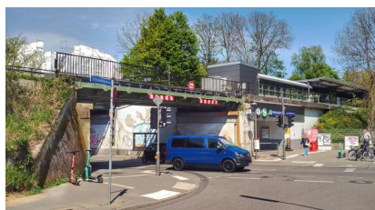
Blick auf die zu erneuernde S-Bahn-Brücke „Rolfinckstraße“ (Mai 2022) [Quelle: DB Netz AG]
