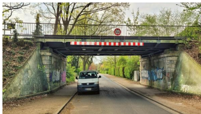
Blick auf die zu erneuernde S-Bahn-Brücke „Hoheneichen“ (Mai 2023) [Quelle: DB Netz AG]
