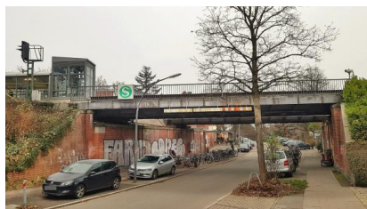
Blick auf die zu erneuernde S-Bahn-Brücke „Tornberg“ (Dezember 2020) [Quelle: DB Netz AG]
