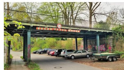
Blick auf die zu erneuernde S-Bahn-Brücke „Borstels Ende“ (Mai 2023) [Quelle: DB Netz AG]
