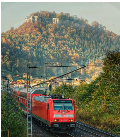
Der Abschnitt Königstein – Bad Schandau mit der erneuerten Oberleitung (Oktober 2021) [Quelle: DB Netz AG/Jörn Daberkow]
