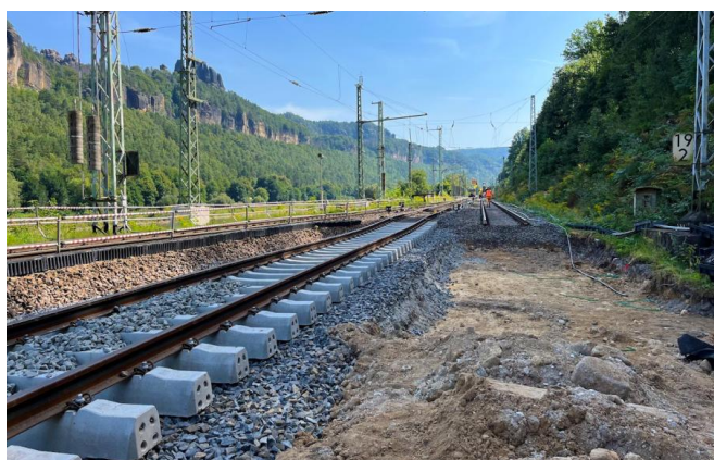
Am Bahnhof Bad Schandau Ost werden die Gleise erneuert (September 2023) [Quelle: DB Netz AG]
