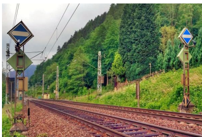
Entlang der Strecke befinden sich verschiedene Fahrleitungssignale für die Triebfahrzeugführenden. Das Signal „Bügel ab“ kennzeichnet die Stelle, an der der Stromabnehmer einer elektrisch betriebenen Lokomotive vollständig abgesenkt sein muss (Juni 2022) [Quelle: DB Netz AG]
