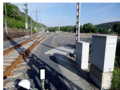
Im Bahnhof Bad Schandau wurde unter anderem das neue Logistik-Gleis 60 errichtet (Mai 2017) (2) [Quelle: DB Netz AG]
