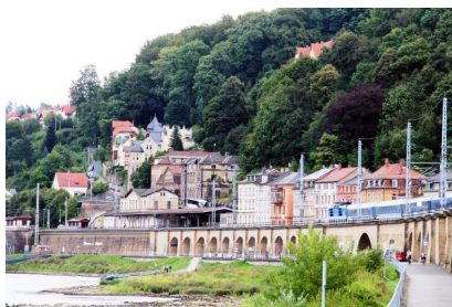
Blick auf den Bahnhof Königstein (August 2016) [Quelle: DB Netz AG/Steffen Burkhardt]
