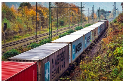
Im Bahnhof Bad Schandau ist vorgesehen, die Oberleitungsanlage zu erneuern (Oktober 2021) [Quelle: DB Netz AG/Jörn Daberkow]
