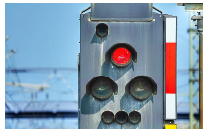
Alle Signale auf der Strecke werden erneuert. Eingesetzt werden dabei sogenannte Kombinationssignale. Diese Signalbauart wurde 1994 eingeführt, um die unterschiedlichen Signalsysteme zu vereinheitlichen (Juli 2022) [Quelle: DB Netz AG]
