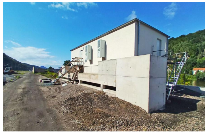
Das Modulgebäude, das ESTW-A Bad Schandau Ost, wurde errichtet (August 2023) [Quelle: DB Netz AG]
