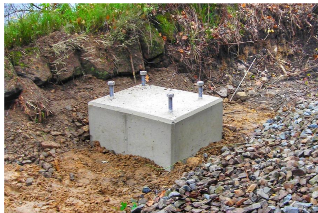
Blick auf das Fundament eines Oberleitungsmasts (November 2015) [Quelle: DB Netz AG]
