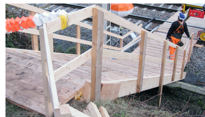
Für Fußgänger:innen und Radfahrer:innen wurde ein Behelfsbahnübergang errichtet (November 2019) [Quelle: DB Netz AG/Albrecht Neumann]
