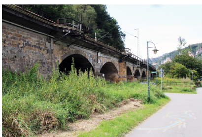
Das Hirschmühlenviadukt vor dem Einbau der neuen Fahrbahnwanne (2) (August 2016) [Quelle: DB Netz AG/Steffen Burkhardt]
