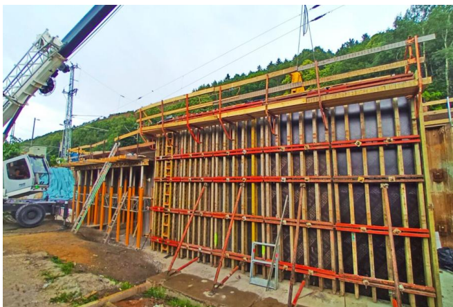
Blick auf den Baufortschritt an der Eisenbahnüberführung im Güterbahnhof Bad Schandau Ost (Juni 2023) [Quelle: DB Netz AG]
