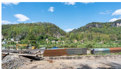
Im Bereich des Güterbahnhofs Bad Schandau Ost verbauen wir neue Spundwände (April 2024) [Quelle: DB InfraGO AG/Jörn Daberkow]
