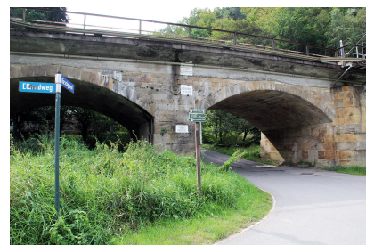
Das Hirschmühlenviadukt vor dem Einbau der neuen Fahrbahnwanne (1) (August 2016) [Quelle: DB Netz AG/Steffen Burkhardt]
