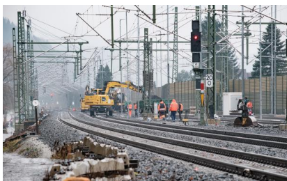
Blick auf die Bahnanlagen am Güterbahnhof Bad Schandau Ost (Dezember 2025) [Quelle: DB InfraGO AG/Jörn Daberkow]
