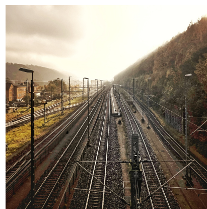
Im Rahmen der Arbeiten werden in Bad Schandau Schienen, Schwellen und Schotter erneuert (Oktober 2021) [Quelle: DB Netz AG/Jörn Daberkow]
