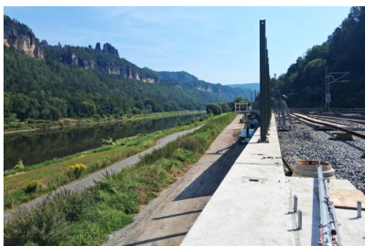
Die neuen Lärmschutzwände und Gleisanlagen zwischen Bad Schandau und Schöna (August 2025) [Quelle: DB InfraGO AG]
