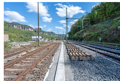
Im Rahmen der Arbeiten erneuern wir die Gleisanlagen am Güterbahnhof Bad Schandau Ost (April 2024) [Quelle: DB InfraGO AG/Jörn Daberkow]
