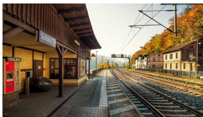
Der erneuerte Oberbau im Bahnhof Schöna (Oktober 2021) [Quelle: DB Netz AG/Jörn Daberkow]
