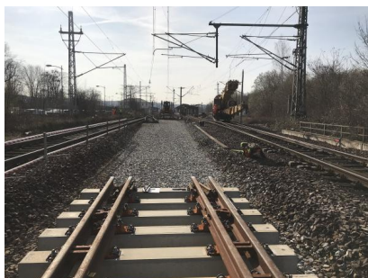
Rund um den Bahnhof Pirna werden neun neue Weichen eingebaut (März 2019) [Quelle: DB Engineering & Consulting/Andrey Kurygin]
