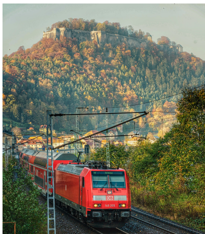
Der Abschnitt Königstein – Bad Schandau mit der erneuerten Oberleitung (Oktober 2021) [Quelle: DB Netz AG/Jörn Daberkow]
