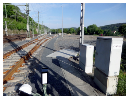
Im Bahnhof Bad Schandau wurde unter anderem das neue Logistik-Gleis 60 errichtet (Mai 2017) (2) [Quelle: DB Netz AG]
