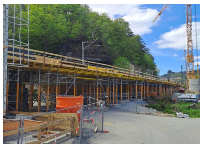
Arbeiten am Hirschmühlenviadukt (April 2026) [Quelle: DB InfraGO AG]
