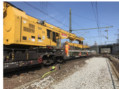
Das erste Gleisstück wird auf dem vorbereiteten Untergrund abgelegt [Quelle: DB Engineering & Consulting/Andrey Kurygin]
