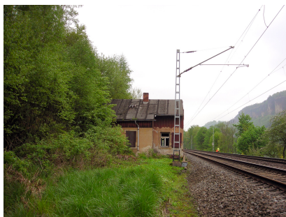
Die alte Oberleitungsanlage zwischen Schöna und Bad Schandau Ost (April 2014) [Quelle: DB Netz AG]
