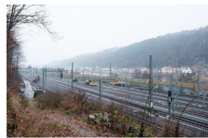
Blick auf die Bahnanlagen am Güterbahnhof Bad Schandau Ost (Dezember 2025) [Quelle: DB InfraGO AG/Jörn Daberkow]
