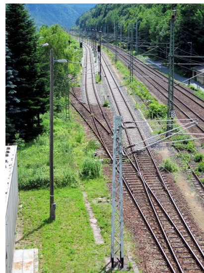
Blick aus dem Stellwerk Bad Schandau Ost in Richtung der Lokwechselgleise (Juni 2012) [Quelle: DB Engineering & Consulting]
