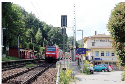
Blick auf den Haltepunkt Wehlen (August 2016) [Quelle: DB Netz AG/Steffen Burkhardt]
