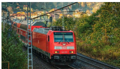
Der Abschnitt Königstein – Bad Schandau mit der erneuerten Oberleitung (Oktober 2021) [Quelle: DB Netz AG/Jörn Daberkow]
