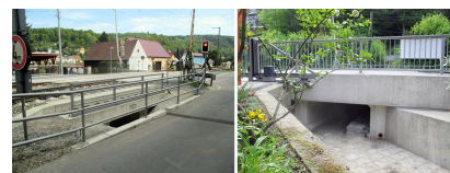
Die neu gebaute Grabenbrücke „Telschgraben“ (Haltepunkt Wehlen) wurde 2016 fertiggestellt (2017) [Quelle: DB Netz AG]
