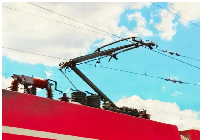
Die Oberleitung auf der Strecke zwischen Schöna und Bad Schandau wird nach über 50 Jahren Nutzung erneuert (Juli 2022) [Quelle: DB Netz AG]
