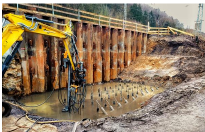
Die Eisenbahnüberführung am Güterbahnhof Bad Schandau Ost wird auf Mikropfählen gegründet (Februar 2023) [Quelle: DB Netz AG]
