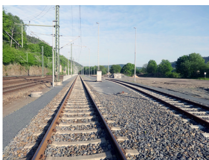
Im Bahnhof Bad Schandau wurde unter anderem das neue Logistik-Gleis 60 errichtet (Mai 2017) (1) [Quelle: DB Netz AG]
