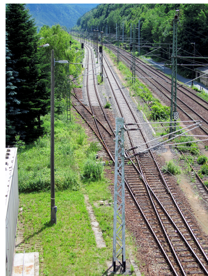
Blick aus dem Stellwerk Bad Schandau Ost in Richtung der Lokwechselgleise (Juni 2012) [Quelle: DB Engineering & Consulting]
