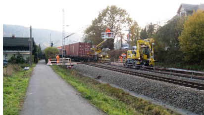
Im Kurort Rathen wird der Oberbau erneuert (November 2019) (1) [Quelle: DB Netz AG/Albrecht Neumann]
