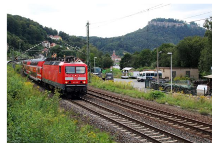
Die Oberleitungsanlage zwischen Bad Schandau und Königstein wurde bereits erneuert (August 2016) [Quelle: DB Netz AG/Steffen Burkhardt]
