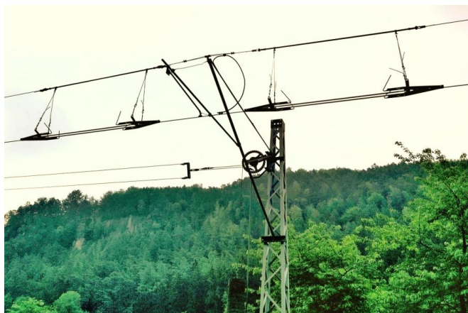
Die Oberleitung an der Systemtrennstelle Deutschland/Tschechien wird nach über 30 Jahren Nutzung erneuert (Juni 2022) [Quelle: DB Netz AG]
