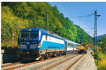
Von Juni 2022 bis Februar 2023 erneuern wir abschnittsweise die Oberleitungsanlage von der Grenze D/CZ bis zum Bahnhof Schöna. In diesem Zeitraum ist der Abschnitt nur eingleisig befahrbar (August 2022) [Quelle: DB Netz AG]
