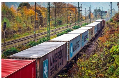
Im Bahnhof Bad Schandau ist vorgesehen, die Oberleitungsanlage zu erneuern (Oktober 2021) [Quelle: DB Netz AG/Jörn Daberkow]
