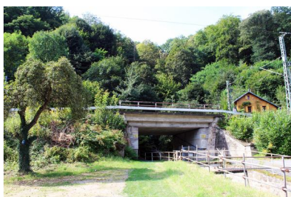
Im Rahmen der Bauarbeiten werden im Oberen Elbtal mehrere Durchlässe instandgesetzt (August 2016) [Quelle: DB Netz AG/Steffen Burkhardt]
