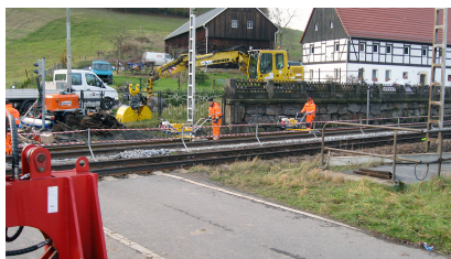
Im Kurort Rathen wird der Oberbau erneuert (November 2019) (2) [Quelle: DB Netz AG/Albrecht Neumann]
