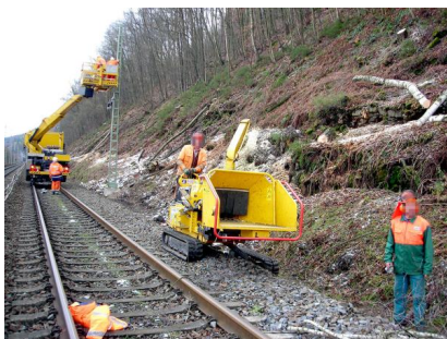
Von November 2014 bis März 2015 sowie von November 2015 bis März 2016 wurde die Oberleitung im Abschnitt zwischen Königstein und Bad Schandau erneuert [Quelle: DB Netz AG]
