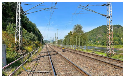
Zwischen dem Güterbahnhof Bad Schandau Ost und dem Bad Schandauer Ortsteil Krippen wird eine Lärmschutzwand errichtet (September 2023) [Quelle: DB Netz AG]
