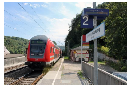
Blick auf den Haltepunkt Obervogelgesang (August 2016) [Quelle: DB Netz AG/Steffen Burkhardt]
