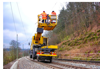
In zwei Bauphasen von Juni 2022 bis Februar 2023 erneuern wir die Oberleitungsanlage von der Grenze D/CZ bis zum Bahnhof Schöna (Juni 2022) [Quelle: DB Netz AG]
