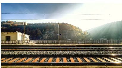
Unter anderem wurden im Bahnhof Schöna Schienen, Schwellen und Schotter erneuert (Oktober 2021) [Quelle: DB Netz AG/Jörn Daberkow]
