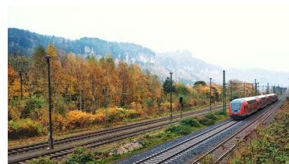
Im Bahnhof Bad Schandau Ost ist auch der Bau von Spund- und Lärmschutzwänden geplant (Oktober 2021) [Quelle: DB Netz AG/Jörn Daberkow]
