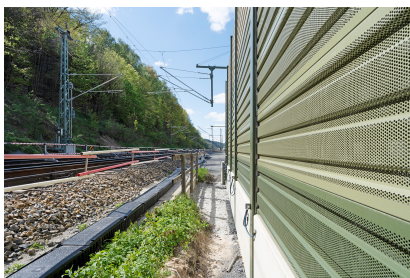
Blick auf eine Lärmschutzwand am Güterbahnhof Bad Schandau Ost (April 2024) [Quelle: DB InfraGO AG/Jörn Daberkow]
