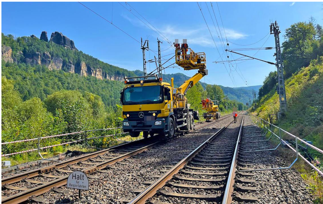
Blick auf ein Zweiwegefahrzeug. Diese können wahlweise auf der Straße oder auf den Gleisen fahren (September 2023) [Quelle: DB Netz AG]
