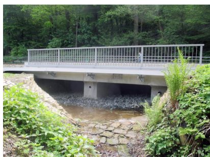
Blick auf die 2016 errichtete Grabenbrücke „Nauendorfer Bach“ zwischen den Haltepunkten Stadt Wehlen und Obervogelgesang (2017) [Quelle: DB Netz AG]
