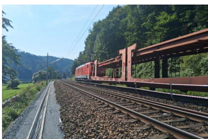
Die neuen Gleisanlagen zwischen Bad Schandau und Schöna (August 2025) [Quelle: DB InfraGO AG]
