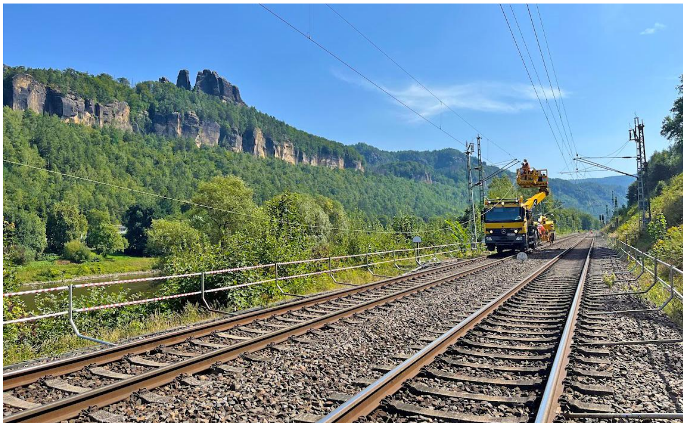
Es ist vorgesehen, im Bereich Schmilka-Hirschmühle eine temporäre Überleitstelle herzustellen (September 2023) [Quelle: DB Netz AG]
