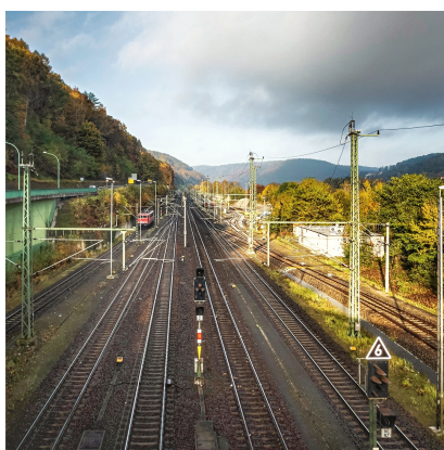
In Bad Schandau ist die Erneuerung des Oberbaus vorgesehen (Oktober 2021) [Quelle: DB Netz AG/Jörn Daberkow]
