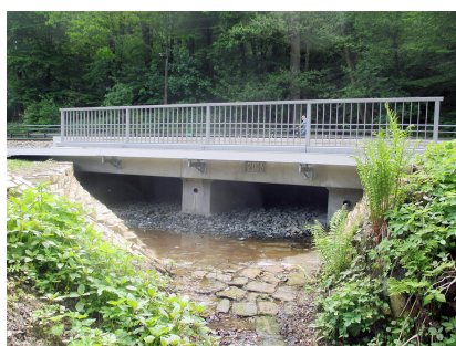
Blick auf die 2016 errichtete Grabenbrücke „Nauendorfer Bach“ zwischen den Haltepunkten Stadt Wehlen und Obervogelgesang (2017) [Quelle: DB Netz AG]
