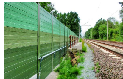
Zwischen dem Güterbahnhof Bad Schandau Ost und dem Bad Schandauer Ortsteil Krippen ist der Bau einer Lärmschutzwand vorgesehen (Juli 2022) [Quelle: DB Netz AG]
