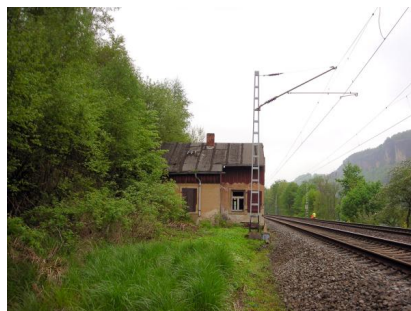
Die alte Oberleitungsanlage zwischen Schöna und Bad Schandau Ost (April 2014) [Quelle: DB Netz AG]
