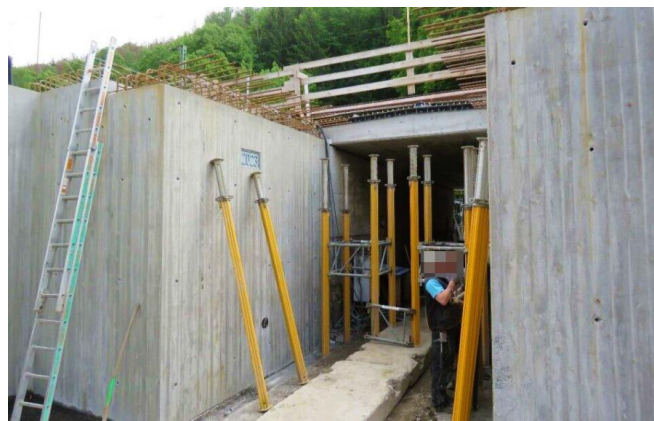
Blick auf den Baufortschritt an der Eisenbahnüberführung im Güterbahnhof Bad Schandau Ost (Mai 2023) [Quelle: DB Netz AG]
