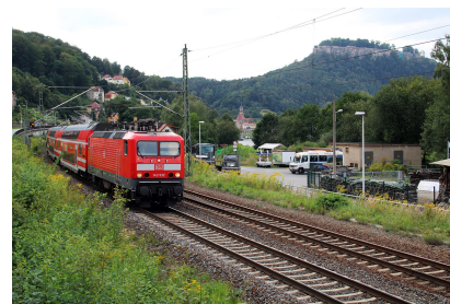
Die Oberleitungsanlage zwischen Bad Schandau und Königstein wurde bereits erneuert (August 2016) [Quelle: DB Netz AG/Steffen Burkhardt]
