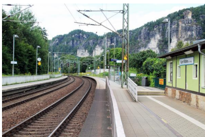
Im Bahnhof Kurort Rathen wird im Laufe der Arbeiten rund ein Kilometer Gleis saniert (August 2016) [Quelle: DB Netz AG/Steffen Burkhardt]
