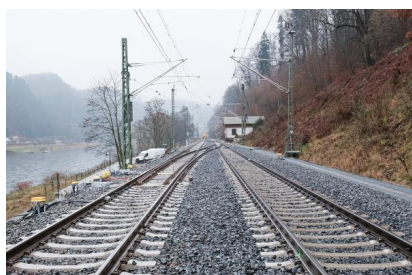
Temporäre Überleitstelle zwischen den beiden Streckengleisen in der Nähe des Haltepunkts Schmilka-Hirschmühle (Dezember 2025) [Quelle: DB InfraGO AG/Jörn Daberkow]
