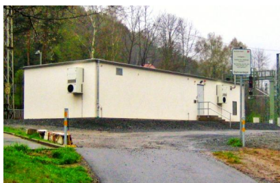
Blick auf das Modulgebäude eines Elektronischen Stellwerks (April 2011) [Quelle: DB Netz AG]
