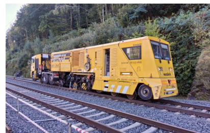
Blick auf einen Schienenschleifzug (September 2025) [Quelle: DB InfraGO AG]
