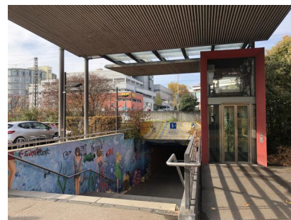
Wir erneuern altersbedingt die Eisenbahnüberführung und die darunter liegende Personenunterführung südlich des Bahnhofs Nürtingen (November 2018) [Quelle: DB Netz AG/Mark Jahns]
