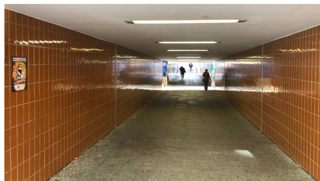
Die Personenunterführung verbindet die Bahnhofstraße mit der Plochinger Straße sowie mit der Neuffener Straße (November 2018) [Quelle: DB Netz AG/Mark Jahns]
