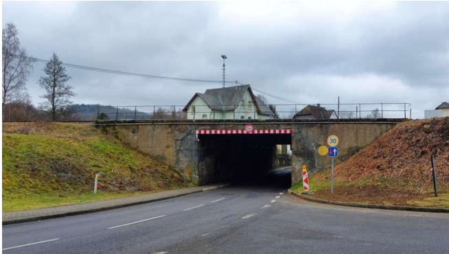
Die Fläche um die Brücke wurde von Bewuchs befreit (Februar 2025) [Quelle: DB InfraGO AG]
