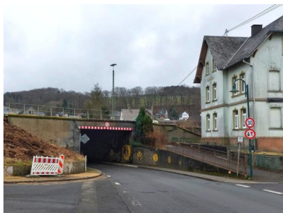
Die Fläche um die Brücke wurde von Bewuchs befreit (Februar 2025) [Quelle: DB InfraGO AG]
