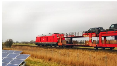
Blick auf die Strecke zwischen Niebüll und Klanxbüll. Es ist geplant, diese zweigleisig auszubauen (März 2021) [Quelle: DB Netz AG]
