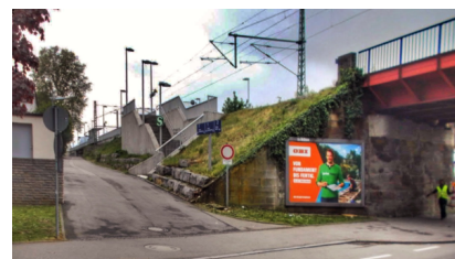
Die Eisenbahnüberführung befindet sich in unmittelbarer Nähe des S-Bahnhofs Neckarsulm Mitte (Mai 2019) [Quelle: AFRY Deutschland GmbH]
