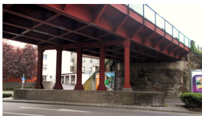
Blick in Richtung Süden auf den unteren Bereich der Eisenbahnüberführung inklusive der Pfeiler (Mai 2019) [Quelle: AFRY Deutschland GmbH]
