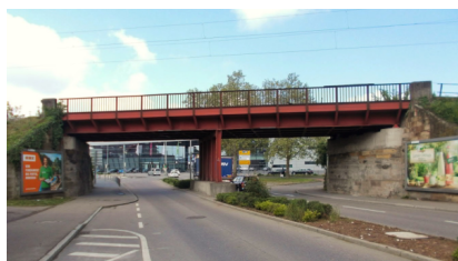
Blick auf die Eisenbahnüberführung aus Richtung Osten (Mai 2019) [Quelle: AFRY Deutschland GmbH]
