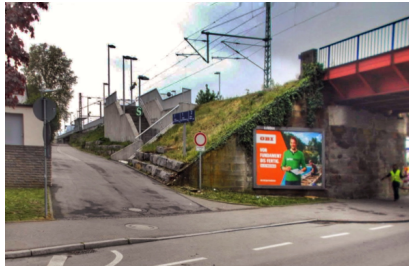
Die Eisenbahnüberführung befindet sich in unmittelbarer Nähe des S-Bahnhofs Neckarsulm Mitte (Mai 2019) [Quelle: AFRY Deutschland GmbH]
