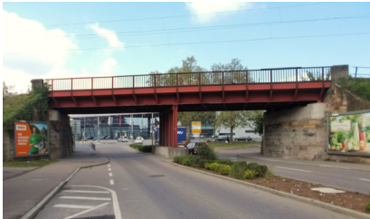
Blick auf die Eisenbahnüberführung aus Richtung Osten (Mai 2019) [Quelle: AFRY Deutschland GmbH]
