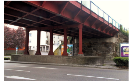
Blick in Richtung Süden auf den unteren Bereich der Eisenbahnüberführung inklusive der Pfeiler (Mai 2019) [Quelle: AFRY Deutschland GmbH]
