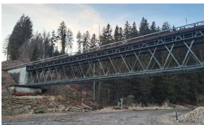
Wir haben die Fläche um die Brücke von Bewuchs befreit, sodass die Baustellenfläche errichtet werden kann (März 2025) [Quelle: DB InfraGO AG]
