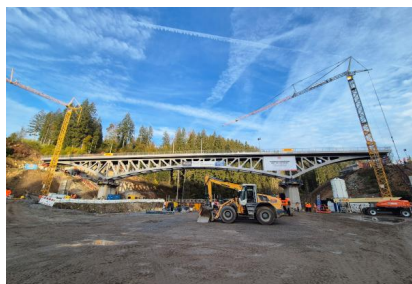
Blick auf die neue Brücke (Oktober 2026) [Quelle: DB InfraGO AG/Melanie Reinfelder]
