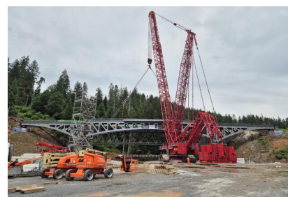
Das letzte Teil der neuen Brücke wird auf seinen Pfeilern platziert. Im Hintergrund ist die alte Brücke zu sehen, auf der gerade ein Zug fährt (Juni 2026) [Quelle: DB InfraGO AG/Melanie Reinfelder]
