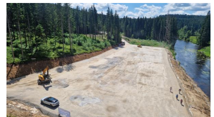
Die sogenannte Baustelleneinrichtungsfläche ist fertig (Juni 2025) [Quelle: DB InfraGO AG]
