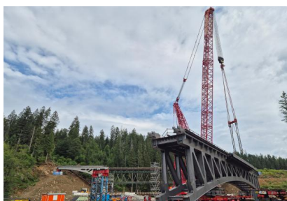
Ein Raupenkran mit einer Traglast von 1.000 Tonnen hebt das Mittelsegment an (Juni 2026) [Quelle: DB InfraGO AG/Melanie Reinfelder]
