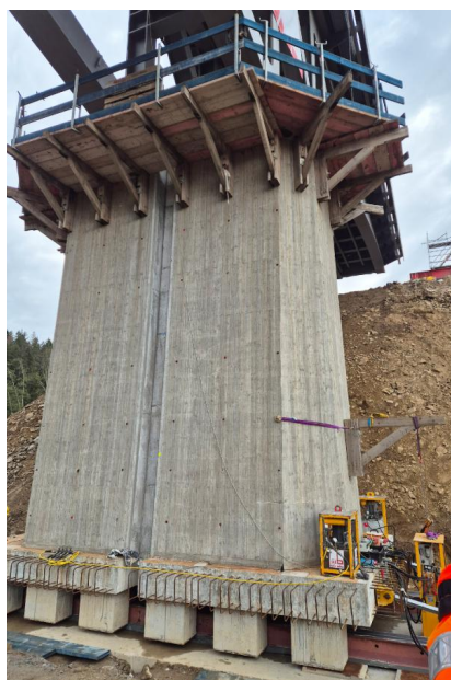
Ein Pfeiler allein bringt rund 800 Tonnen auf die Waage (Oktober 2026) [Quelle: DB InfraGO AG/Melanie Reinfelder]
