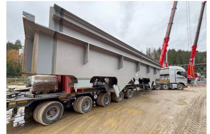
Die einzelnen Teile der Stahlträger werden angeliefert (Oktober 2025) [Quelle: DB InfraGO AG/Eliana Schmidt]
