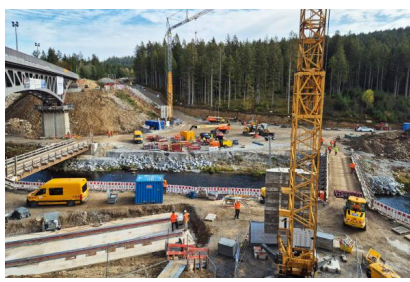
Die Bauarbeiten sind in vollem Gange (Oktober 2026) [Quelle: DB InfraGO AG/Melanie Reinfelder]
