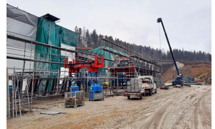
Um geeignete Temperaturen und eine passende Luftfeuchtigkeit für die Schweißarbeiten an den Stahlträgern sicherzustellen, ist das Gerüst verkleidet (Dezember 2025) [Quelle: DB InfraGO AG/Melanie Reinfelder]
