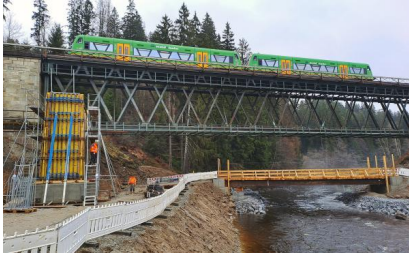
Während an der Baustelle gearbeitet wird, läuft der Betrieb der Waldbahn weiter und die Züge fahren über die Bestandsbrücke (Dezember 2025) [Quelle: DB InfraGO AG/Melanie Reinfelder]
