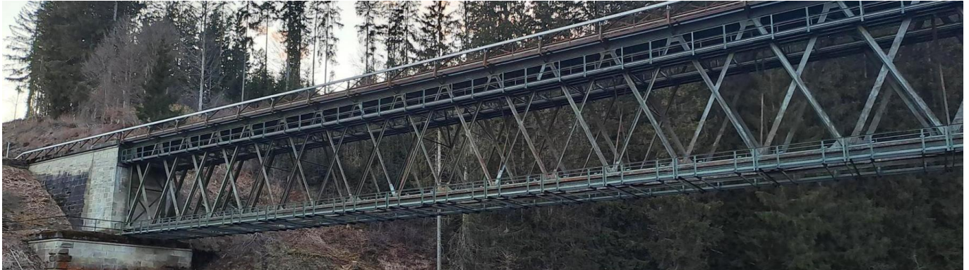
Wir haben die Fläche um die Brücke von Bewuchs befreit, sodass die Baustellenfläche errichtet werden kann (März 2025) [Quelle: DB InfraGO AG]
