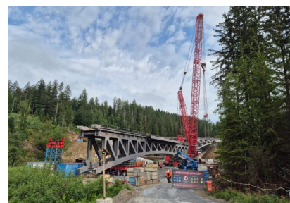
Der Raupenkran ist aufgebaut und das Mittelsegment ist noch prominent am Eingang der Baustelle platziert (Juni 2026) [Quelle: DB InfraGO AG/Melanie Reinfelder]
