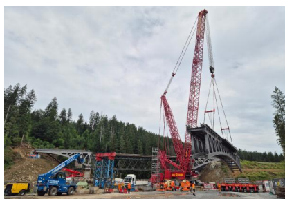
Das 480 Tonnen schwere Brückenteil wird in Position gebracht (Juni 2026) [Quelle: DB InfraGO AG/Melanie Reinfelder]
