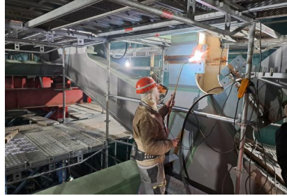
Im Inneren des Gerüsts werden die einzelnen Stahlteile der neuen Brückenträger miteinander verschweißt (Dezember 2025) [Quelle: DB InfraGO AG/Melanie Reinfelder]
