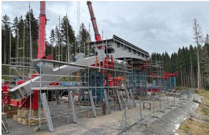
Vor Ort verschweißen wir die einzelnen Teile der Stahlträger (Oktober 2025) [Quelle: DB InfraGO AG/Eliana Schmidt]
