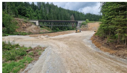
Mittlerweile ist auch eine Zufahrtsstraße zur Baustelle gebaut (Juni 2025) [Quelle: DB InfraGO AG]
