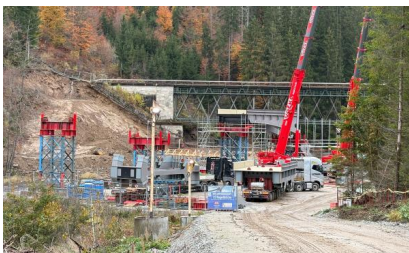
Die einzelnen Teile der Stahlträger werden angeliefert (Oktober 2025) [Quelle: DB InfraGO AG/Eliana Schmidt]
