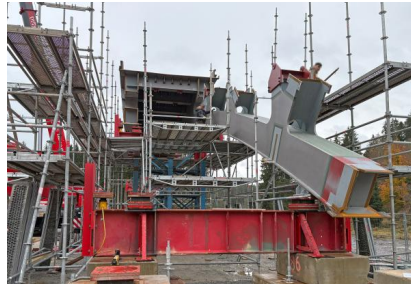
Vor Ort verschweißen wir die einzelnen Teile der Stahlträger (Oktober 2025) [Quelle: DB InfraGO AG/Eliana Schmidt]
