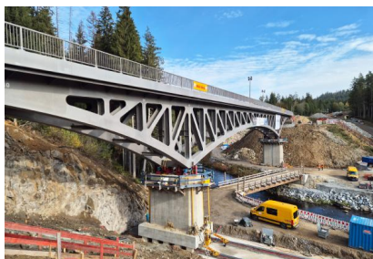
Die Brücke wurde mitsamt den beiden Pfeilern um 20 Meter auf Bahnen verschoben und ist nun in ihrer finalen Lage (Oktober 2026) [Quelle: DB InfraGO AG/Melanie Reinfelder]
