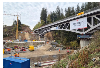
Die 120 Meter lange Brücke wiegt 2.500 Tonnen (Oktober 2026) [Quelle: DB InfraGO AG/Melanie Reinfelder]
