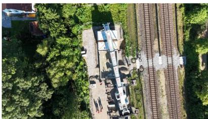
Drohenaufnahme: Bauarbeiten am neuen Stellwerksgebäude in Thann-Matzbach – ein Kran hebt die Gebäudemodule an (Juli 2025) [Quelle: DB InfraGO AG]
