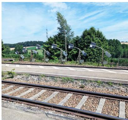
Blick auf das Spannwerk für die Seilzuganlagen des mechanischen Stellwerks in Thann-Matzbach (Juli 2023) [Quelle: DB Netz AG]
