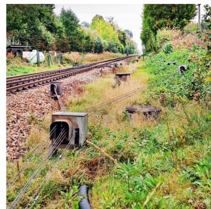
Blick auf Seilzuganlagen. Diese sind Teil der Außenanlagen eines mechanischen Stellwerks (Oktober 2023) [Quelle: DB Netz AG]
