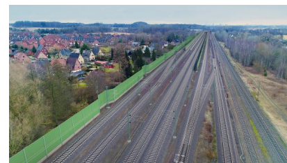
Visualisierung: Im Rahmen der Erweiterung des Überwerfungsbauwerk in Meckelfeld werden auch Schallschutzwände errichtet (Stand: Januar 2019) (3) [Quelle: VECTORVISION GbR]
