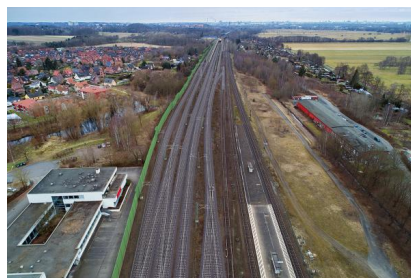
Visualisierung: Im Rahmen der Erweiterung des Überwerfungsbauwerk in Meckelfeld werden auch Schallschutzwände errichtet (Stand: Januar 2019) (2) [Quelle: VECTORVISION GbR]
