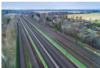
Visualisierung: Im Rahmen der Erweiterung des Überwerfungsbauwerk in Meckelfeld werden auch Schallschutzwände errichtet (Stand: Januar 2019) (1) [Quelle: VECTORVISION GbR]
