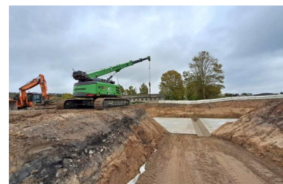
Blick auf das Fundament der künftigen Eisenbahnüberführung am Zickhusener Weg (Oktober 2025) [Quelle: DB InfraGO AG]
