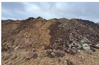
Da der Boden unter anderem aus Torf und Lehm besteht, müssen wir durch das Rüttelstopfverfahren punktuell ein Kies-Sand-Gemisch zur Befestigung des Bodens einbringen (Oktober 2025) [Quelle: DB InfraGO AG]
