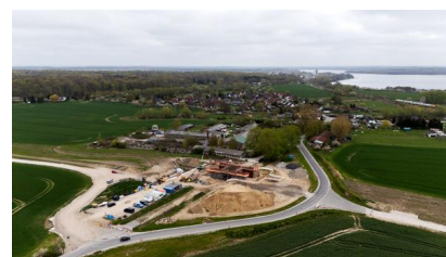
Blick auf das Fundament der künftigen Eisenbahnüberführung bei Gallentin (April 2026) [Quelle: HTG Projektmanagement GmbH]
