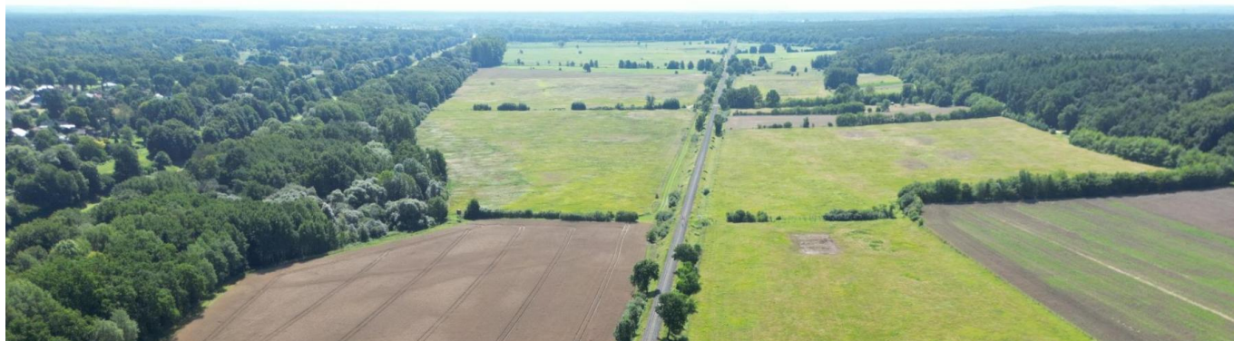
Blick auf die Bahnstrecke bei Grambek (August 2025) [Quelle: GEOBAY PartG mbB beratende Ingenieure]
