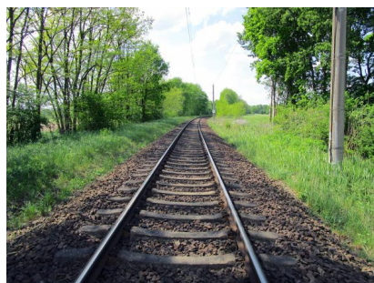
Blick entlang der eingleisigen Strecke Lübbenau – Cottbus (Mai 2016) [Quelle: DB Netz AG]
