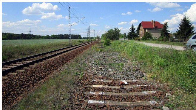
Visualisierung: Es ist geplant, die Strecke zwischen Lübbenau und Cottbus um ein zweites Gleis zu erweitern (Juli 2019) [Quelle: DB Netz AG]
