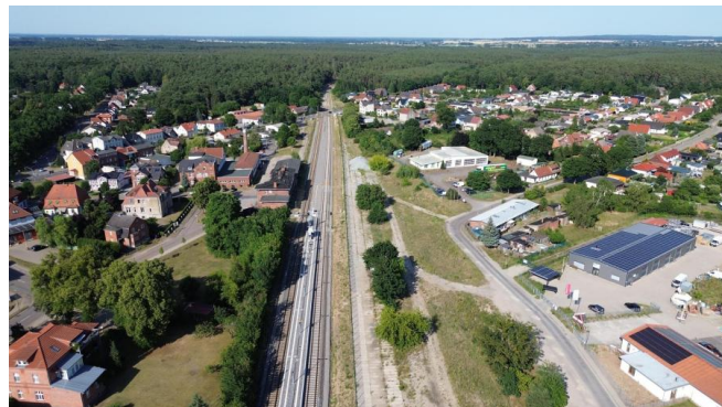
Blick auf den teils umgebauten Bahnhof Neustadt-Glewe (Juli 2025) [Quelle: DB InfraGO AG]
