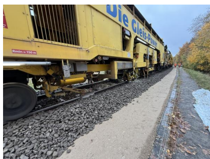
Blick auf „Katharina die Große“ – eine Bettungsreinigungs- und Planumssanierungsmaschine (Oktober 2025) [Quelle: DB InfraGO AG]
