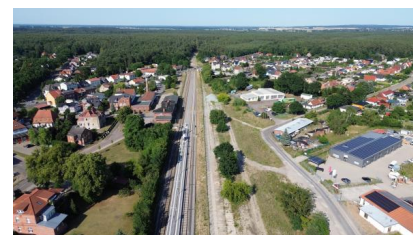
Blick auf den teils umgebauten Bahnhof Neustadt-Glewe (Juli 2025) [Quelle: DB InfraGO AG]
