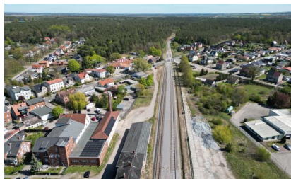
Die Arbeiten an der Strecke sind abgeschlossen (April 2026) [Quelle: DB InfraGO AG]
