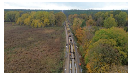
Blick auf „Katharina die Große“ – eine Bettungsreinigungs- und Planumssanierungsmaschine (Oktober 2025) [Quelle: DB InfraGO AG]
