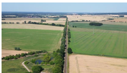
Auf der Strecke zwischen Ludwigslust und Parchim sind umfangreiche Erneuerungen vorgesehen (Juli 2025) [Quelle: DB InfraGO AG]
