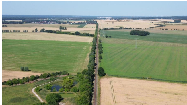
Auf der Strecke zwischen Ludwigslust und Parchim sind umfangreiche Erneuerungen vorgesehen (Juli 2025) [Quelle: DB InfraGO AG]
