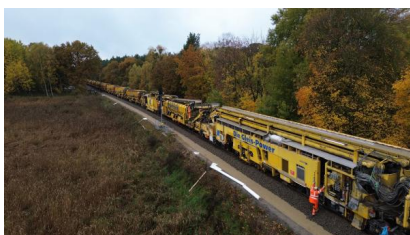
Blick auf „Katharina die Große“ – eine Bettungsreinigungs- und Planumssanierungsmaschine (Oktober 2025) [Quelle: DB InfraGO AG]
