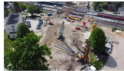
Die Baustelle aus der Vogelperspektive (Mai 2022) [Quelle: DB Netz AG]
