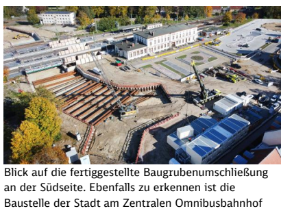
Blick auf die fertiggestellte Baugrubenumschließung an der Südseite. Ebenfalls zu erkennen ist die Baustelle der Stadt am Zentralen Omnibusbahnhof (Oktober 2022) [Quelle: DB Netz AG]
