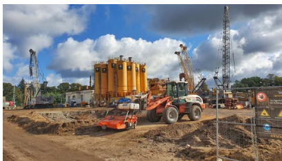
Blick auf die Baustelleneinrichtung und Säulen, die das Bentonit zur Herstellung der Schlitzwände beinhalten (Oktober 2021) [Quelle: DB Netz AG]
