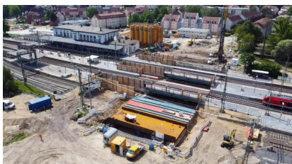
Im Vordergrund sind die eingehobenen Hilfsbrücken sichtbar. Im Hintergrund befindet sich die Baustellenfläche mit den markanten Säulen, welche das Bentonit für die Bauarbeiten enthalten (Mai 2022) [Quelle: DB Netz AG]
