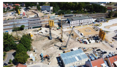
Blick auf die Baustelle aus der Vogelperspektive (August 2022) [Quelle: DB Netz AG]
