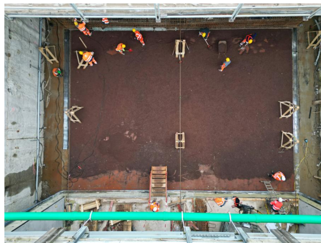
Die Arbeiten aus der Vogelperspektive (Februar 2024) [Quelle: Implenja Deutschland GmbH]
