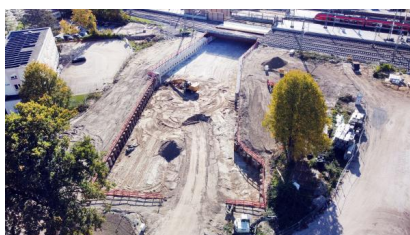
Die Baugrubenumschließung an der Nordseite wurde fertiggestellt (Oktober 2022) [Quelle: DB Netz AG]
