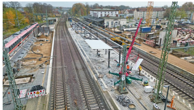
Wir haben die provisorischen Behelfsbahnsteige zurück- und die Bahnsteige wieder aufgebaut (November 2024) [Quelle: DB InfraGO AG]
