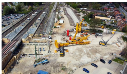
Der Einhub der Hilfsbrücken wird vorbereitet (Mai 2022) [Quelle: DB Netz AG]
