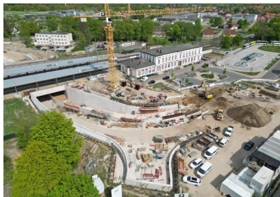
Blick auf den Baufortschritt an der Eisenbahnüberführung (April 2025) [Quelle: DB InfraGO AG]
