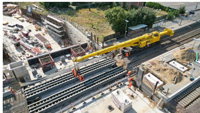
Die Hilfsbrücken werden ausgehoben (August 2024) [Quelle: DB InfraGO AG]
