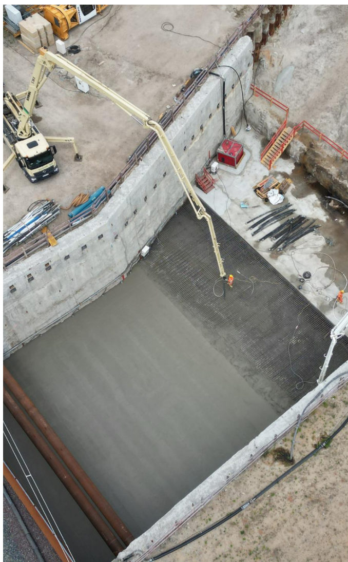
Wir haben die Verschubbahn betoniert (Juni 2023) [Quelle: DB Netz AG]
