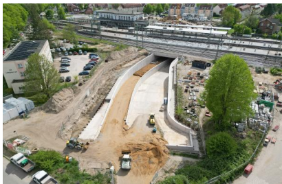
Blick auf den Baufortschritt an der Eisenbahnüberführung (April 2025) [Quelle: DB InfraGO AG]
