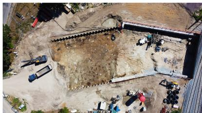
Die Baugrube für den Einbau von Dauerankern auf der Nordseite wurde ausgehoben (August 2022) [Quelle: DB Netz AG]
