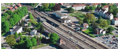
Blick auf den Bahnhof Ludwigslust vor dem Umbau [Quelle: DB Netz AG/FALCON CREST AIR]
