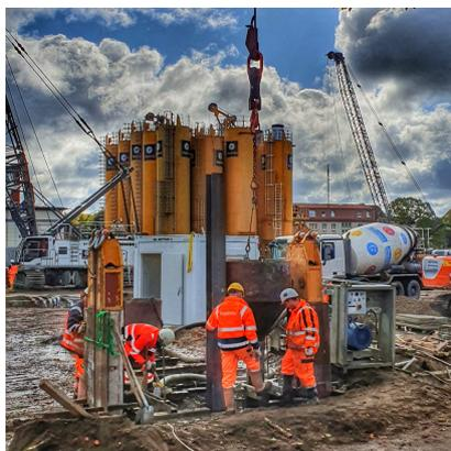
Die Bauarbeiter füllen mit einem Trichter Beton in die vorbereiteten Stützwände, die später die Baugrube
