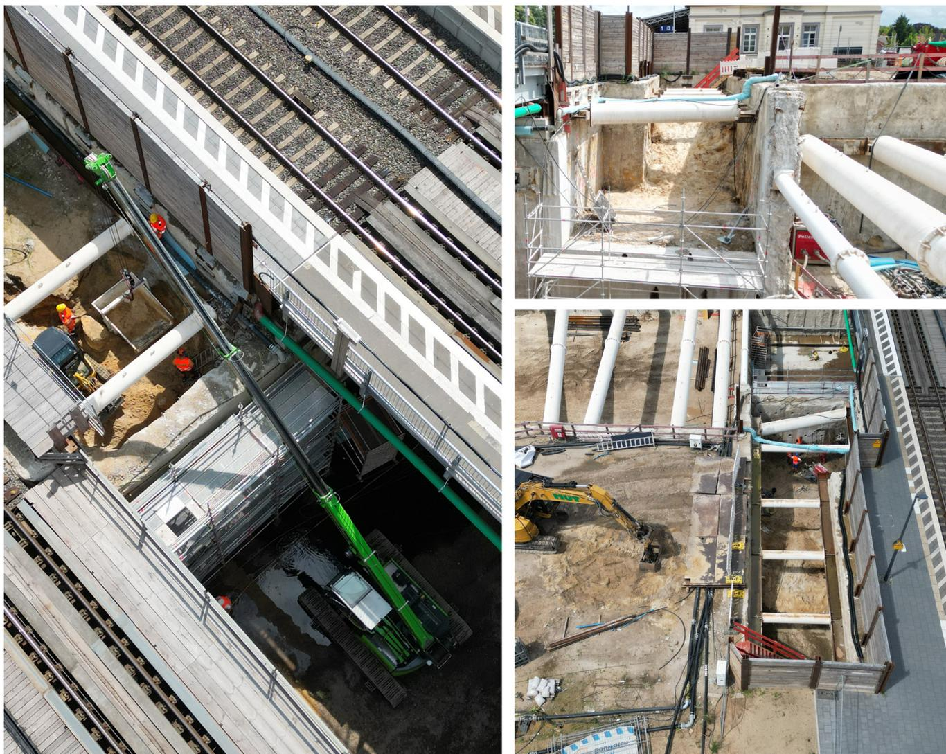
Die Schlitzwand zwischen der Eisenbahnüberführung und dem Treppenabgang des Bahnsteigs 1 wurde mittels einer Seilsäge eingeschnitten, um dort einen Zugang zu schaffen. Mit Hilfe eines sogenannten Ketten-Sennebogens wurden zudem Aushubarbeiten im Treppenabgang des Bahnsteigs 2/3 durchgeführt (Juli 2023) [Quelle: DB Netz AG]
