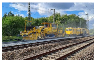
Eine Schotterverteiler- und Planiermaschine im Einsatz (September 2025) [Quelle: DB InfraGO AG]
