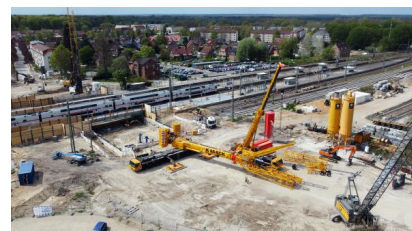
Für den Einhub der Hilfsbrücken werden vorbereitende Arbeiten durchgeführt (Mai 2022) [Quelle: DB Netz AG]
