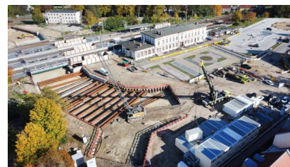
Blick auf die fertiggestellte Baugrubenumschließung an der Südseite. Ebenfalls zu erkennen ist die Baustelle der Stadt am Zentralen Omnibusbahnhof (Oktober 2022) [Quelle: DB Netz AG]
