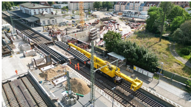
Die Hilfsbrücken werden ausgehoben (August 2024) [Quelle: DB InfraGO AG]
