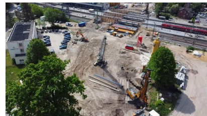
Die Baustelle aus der Vogelperspektive (Mai 2022) [Quelle: DB Netz AG]
