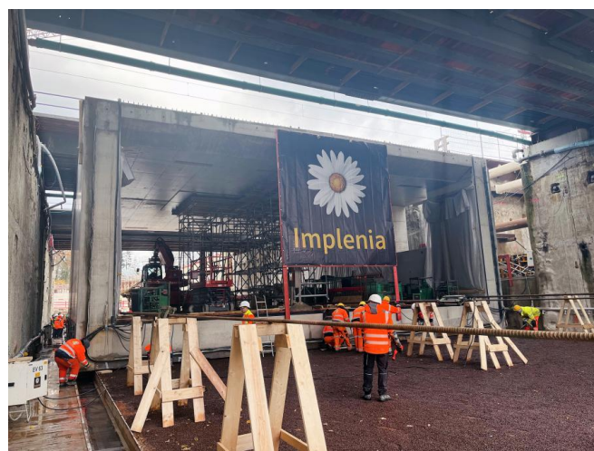
Blick auf den Vershub des ersten Vollrahmenelements (November 2023) [Quelle: DB Netz AG]
