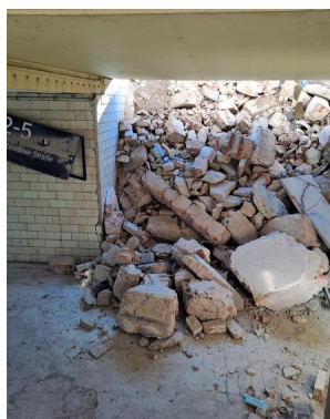
Wir bauen die alte Personenunterführung zurück (September 2025) [Quelle: DB InfraGO AG]
