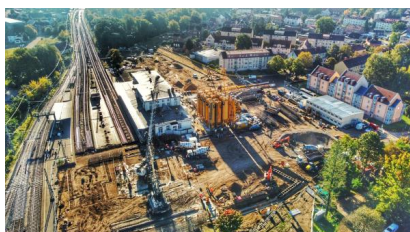
Die Baustelle aus der Vogelperspektive (Oktober 2021) [Quelle: DB Netz AG]
