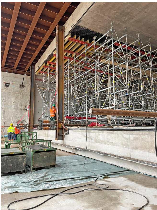
Blick auf die Rahmenkonstruktion (Februar 2024) [Quelle: DB InfraGO AG]
