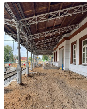
Blick auf den Baufortschritt am Hausbahnsteig (September 2025) [Quelle: DB InfraGO AG]
