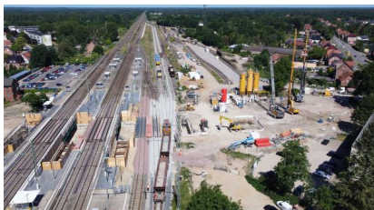
Die Sonderkonstruktion für die Weiche 15 wurde fertiggestellt (Juni 2022) [Quelle: DB Netz AG]
