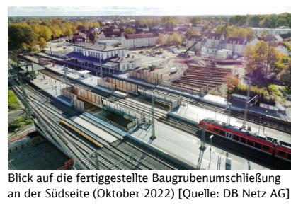
Blick auf die fertiggestellte Baugrubenumschließung an der Südseite (Oktober 2022) [Quelle: DB Netz AG]
