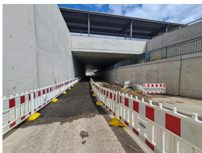
Der provisorische Weg durch die Eisenbahnüberführung ist für Fußgehende und Radfahrende frei (August 2025) [Quelle: DB InfraGO AG]
