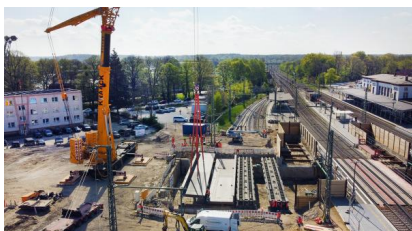
Die Hilfsbrücken wurden am 5. Mai 2022 eingehoben (Mai 2022) [Quelle: DB Netz AG]
