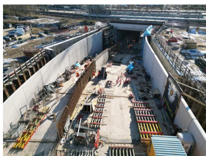
Blick auf den Baufortschritt in Richtung des Troges (Februar 2025) [Quelle: DB InfraGO AG]
