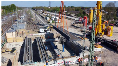
Die Hilfsbrücken wurden am 5. Mai 2022 eingehoben (Mai 2022) [Quelle: DB Netz AG]
