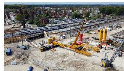
Für den Einhub der Hilfsbrücken werden vorbereitende Arbeiten durchgeführt (Mai 2022) [Quelle: DB Netz AG]
