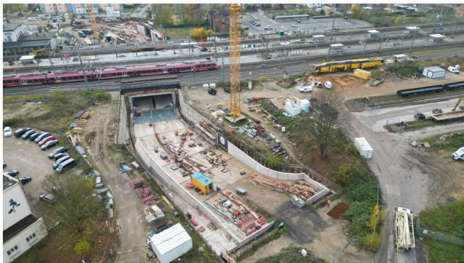
Blick auf den Baufortschritt an der Eisenbahnüberführung (November 2024) [Quelle: DB InfraGO AG]
