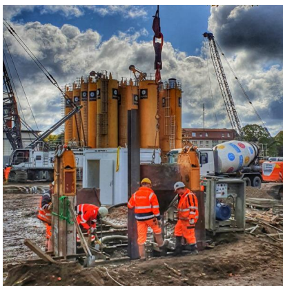
Die Bauarbeiter füllen mit einem Trichter Beton in die vorbereiteten Stützwände, die später die Baugrube umschließen werden (Oktober 2021) [Quelle: DB Netz AG]
