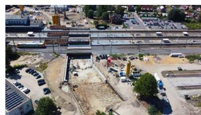
Blick auf die Baugrube auf der Nordseite (August 2022) [Quelle: DB Netz AG]
