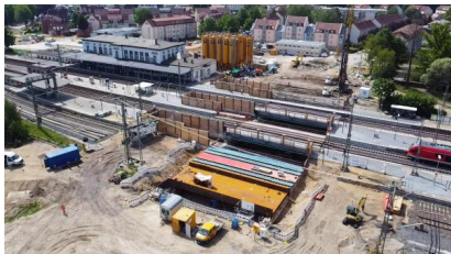
Im Vordergrund sind die eingehobenen Hilfsbrücken sichtbar. Im Hintergrund befindet sich die Baustellenfläche mit den markanten Säulen, welche das Bentonit für die Bauarbeiten enthalten (Mai 2022) [Quelle: DB Netz AG]
