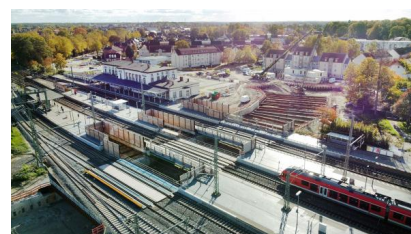
Blick auf die fertiggestellte Baugrubenumschließung an der Südseite (Oktober 2022) [Quelle: DB Netz AG]
