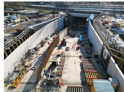
Blick auf den Baufortschritt in Richtung des Trog (Februar 2025) [Quelle: DB InfraGO AG]
