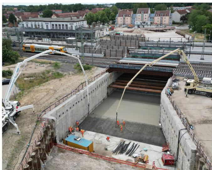
Wir haben die Verschubbahn betoniert (Juni 2023) [Quelle: DB Netz AG]
