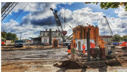
Ein Schlitzwandbagger steht in dem Umbaubereich, wo später die Straßenunterführung entsteht (Oktober 2021) [Quelle: DB Netz AG]
