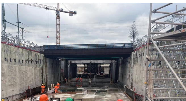
Blick auf den Vershub des ersten Vollrahmenelements (November 2023) [Quelle: DB Netz AG]
