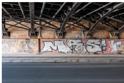
Unterseite der Eisenbahnbrücke über die Pittlerstraße (Juli 2025) [Quelle: DB InfraGO AG/Jörn Daberkow]
