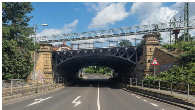
Blick auf die Eisenbahnbrücke über die Linkelstraße in Richtung Pater-Gordian-Straße (Juli 2025) [Quelle: DB InfraGO AG/Jörn Daberkow]
