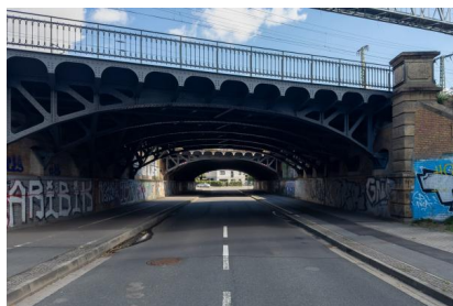
Die Eisenbahnbrücke über die Pittlerstraße in Richtung Pater-Gordian-Straße (Juli 2025) [Quelle: DB InfraGO AG/Jörn Daberkow]
