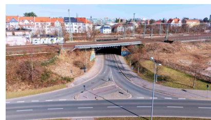
Die Eisenbahnbrücke über die Pittlerstraße vor Beginn der Bauarbeiten (Februar 2026) [Quelle: DB InfraGO AG/Jürgen Findeisen]
