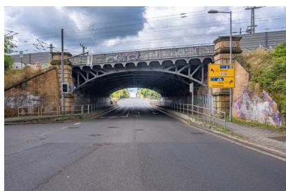
Die Eisenbahnbrücke über die Linkelstraße in Richtung Travniker Straße (Juli 2025) [Quelle: DB InfraGO AG/Jörn Daberkow]
