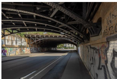
Der untere Bereich der Eisenbahnbrücke über die Pittlerstraße (Juli 2025) [Quelle: DB InfraGO AG/Jörn Daberkow]
