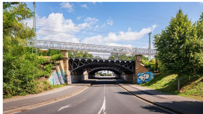
Blick auf die Eisenbahnbrücke über die Pittlerstraße in Richtung Pater-Gordian-Straße (Juli 2025) [Quelle: DB InfraGO AG/Jörn Daberkow]
