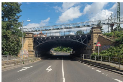
Blick auf die Eisenbahnbrücke über die Linkelstraße in Richtung Pater-Gordian-Straße (Juli 2025) [Quelle: DB InfraGO AG/Jörn Daberkow]
