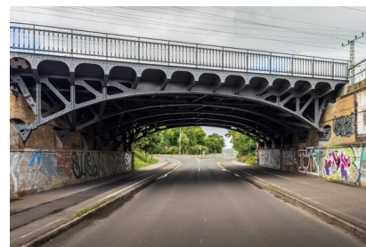
Die Eisenbahnbrücke über die Pittlerstraße in Richtung Neue Hallesche Straße (Juli 2025) [Quelle: DB InfraGO AG/Jörn Daberkow]
