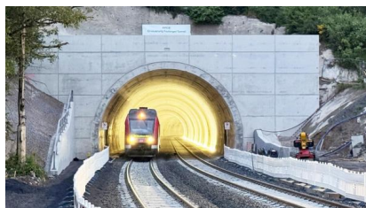
Um kurz vor halb sechs Uhr fuhr am 15. Mai 2026 der erste Personenzug durch den aufgeweiteten und erneuerten Fachinger Tunnel (Mai 2026) [Quelle: DB InfraGO AG]
