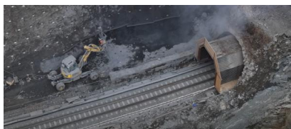
YouTube: Vorbereitung und Durchführung der ersten Lockerungssprengung für die Aufweitung des Cramberger Tunnels (Dezember 2023) [Quelle: DB Netz AG]
