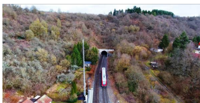
Blick vom Haltepunkt Fachingen auf das westliche Tunnelportal des Fachinger Tunnels (März 2020) [Quelle: DB Netz AG]
