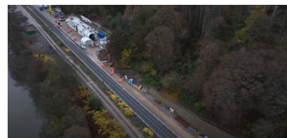
YouTube: Transport des Tunnelaufweitungssystems vor den Cramberger Tunnel (Mai 2024) [Quelle: DB InfraGO AG]
