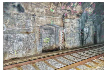
Innenansicht des Villmarer Tunnels (Februar 2019) [Quelle: DB Netz AG]
