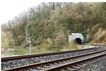
Der Villmarer Tunnel ist eines von sechs Tunnelbauwerken, die auf der Lahntalbahn erneuert werden (Februar 2020) [Quelle: DB Netz AG]
