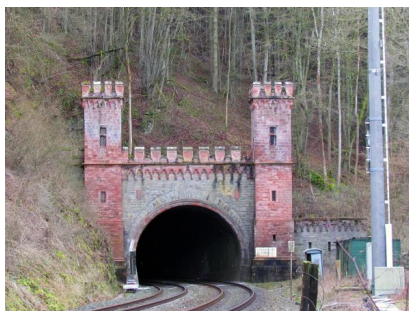
Voraussichtlich 2023 beginnen die Arbeiten zur Erneuerung des Cramberger Tunnels (März 2015) [Quelle: DB Netz AG]
