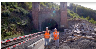
YouTube: Anzuwendende Bauverfahren im Rahmen der Erneuerung des Cramberger Tunnels (August 2023) [Quelle: DB Netz AG]
