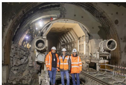
Der Tunnelvortrieb konnte dank des Tunnelaufweitungssystems am 21. November 2024 mit dem „Durchschlag“ des letzten Tunnelmeters vollendet werden (November 2024) [Quelle: DB InfraGO AG]
