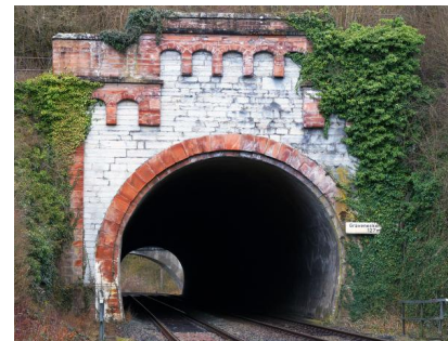
Das Südportal des Grävenecker Tunnels (Februar 2020) [Quelle: DB Netz AG]
