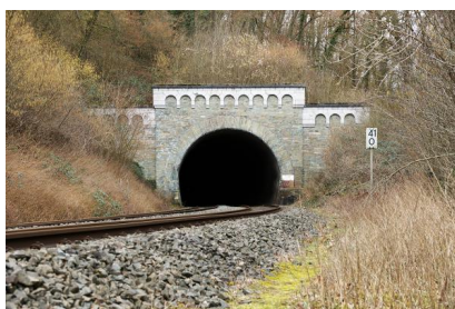
Das Südportal des Villmarer Tunnels (Februar 2020) [Quelle: DB Netz AG]
