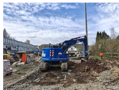
Mit schwerem Gerät arbeiten die Bauteams in Fachingen am neuen Oberbau samt Gleiskörper (April 2026) [Quelle: DB InfraGO AG]
