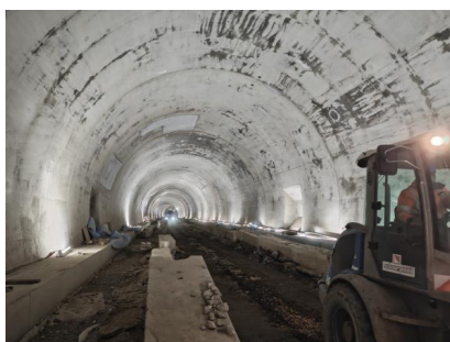
Im Fachinger Tunnel verlegen die Bauteams neue Gleise und sorgen so dafür, dass die Tunnelröhre ab Mai 2026 wieder zweigleisig befahrbar ist (April 2026) [Quelle: DB InfraGO AG]
