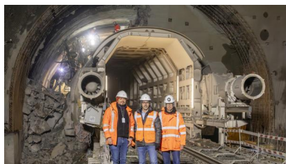
Der Tunnelvortrieb konnte dank des Tunnelaufweitungssystems am 21. November 2024 mit dem „Durchschlag“ des letzten Tunnelmeters vollendet werden (November 2024) [Quelle: DB InfraGO AG]
