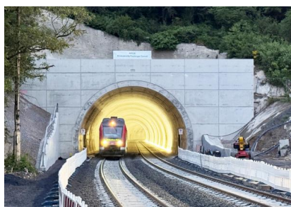
Um kurz vor halb sechs Uhr fuhr am 15. Mai 2026 der erste Personenzug durch den aufgeweiteten und erneuerten Fachinger Tunnel (Mai 2026) [Quelle: DB InfraGO AG]
