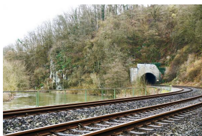
Der Villmarer Tunnel ist eines von sechs Tunnelbauwerken, die auf der Lahntalbahn erneuert werden (Februar 2020) [Quelle: DB Netz AG]
