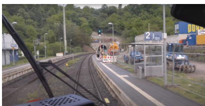
YouTube: Bauvorbereitende Arbeiten für die Erneuerung des Fachinger Tunnels (Juni 2023) [Quelle: DB Netz AG]
