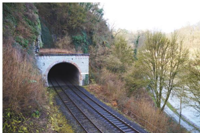
Das Nordportal des Grävenecker Tunnels (Februar 2020) [Quelle: DB Netz AG]
