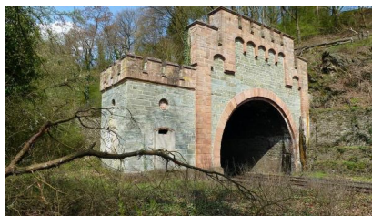
Es ist geplant, entlang der Lahntalbahn sechs Tunnel zu erneuern [Quelle: DB Netz AG]
