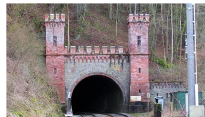
Voraussichtlich 2023 beginnen die Arbeiten zur Erneuerung des Cramberger Tunnels (März 2015) [Quelle: DB Netz AG]
