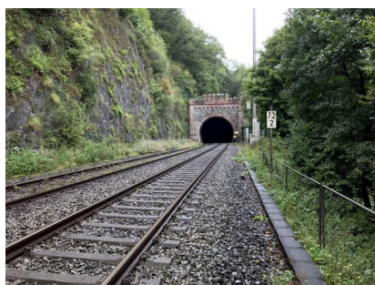
Blick auf das östliche Tunnelportal des Kalkofener Tunnels (September 2017) [Quelle: DB Netz AG]
