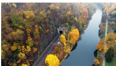
An den Portalen des Kalkofener Tunnels ist geplant, die Voreinschnitte anzupassen (März 2020) [Quelle: DB Netz AG]
