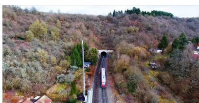
Blick vom Haltepunkt Fachingen auf das westliche Tunnelportal des Fachinger Tunnels (März 2020) [Quelle: DB Netz AG]
