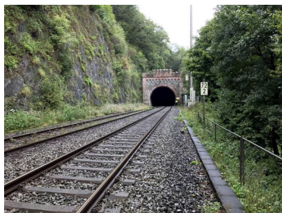
Blick auf das östliche Tunnelportal des Kalkofener Tunnels (September 2017) [Quelle: DB Netz AG]
