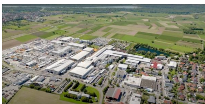
YouTube: Herstellung der Tunnelaufweitungsmaschine für den Cramberger Tunnel (September 2023) [Quelle: DB Netz AG]
