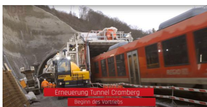
YouTube: Beginn der Aufweitung des Cramberger Tunnels (Juli 2024) [Quelle: DB InfraGO AG]
