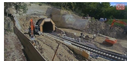
YouTube: Bauvorbereitende Arbeiten für die Erneuerung des Fachinger Tunnels (Oktober 2023) [Quelle: DB InfraGO AG]
