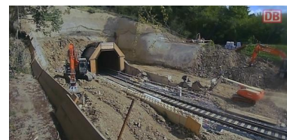
YouTube: Bauvorbereitende Arbeiten für die Erneuerung des Fachinger Tunnels (Oktober 2023) [Quelle: DB InfraGO AG]
