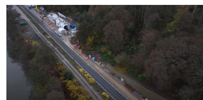
YouTube: Transport des Tunnelaufweitungssystems vor den Cramberger Tunnel (Mai 2024) [Quelle: DB InfraGO AG]
