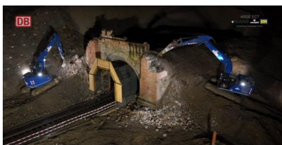
YouTube: Rückbau des Ostportals des Cramberger Tunnels (April 2024) [Quelle: DB InfraGO AG]
