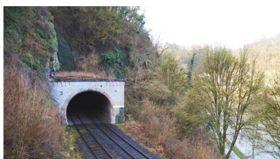
Das Nordportal des Grävenecker Tunnels (Februar 2020) [Quelle: DB Netz AG]
