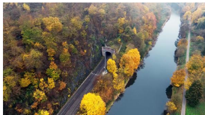
An den Portalen des Kalkofener Tunnels ist geplant, die Voreinschnitte anzupassen (März 2020) [Quelle: DB Netz AG]
