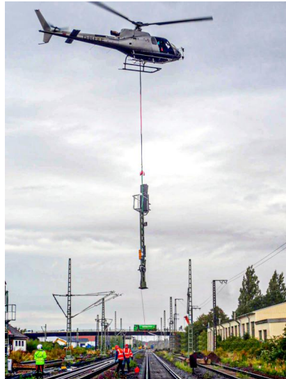
Rund um den Bahnhof Köthen wurden per Helikopter neue Signale gestellt (Oktober 2019) (2) [Quelle: DB Engineering & Consulting GmbH/Bernd Wille]
