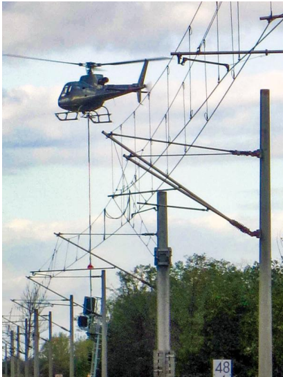
Rund um den Bahnhof Köthen wurden per Helikopter neue Signale gestellt (Oktober 2019) (1) [Quelle: DB Engineering & Consulting GmbH/Bernd Wille]
