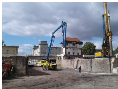
An der Eisenbahnüberführung (EÜ) „Friedrich-Ebert-Straße“ in Köthen werden Gründungsarbeiten für die Hilfsbrücken durchgeführt (2) (Stand: September 2019) [Quelle: DB Netz AG]
