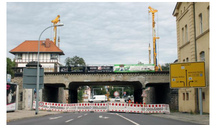
An der Eisenbahnüberführung (EÜ) „Friedrich-Ebert-Straße“ in Köthen werden Gründungsarbeiten für die Hilfsbrücken durchgeführt (1) (Stand: September 2019) [Quelle: DB Netz AG/Judith Hübner]
