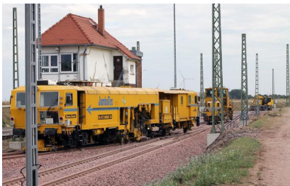
Am Bahnhof Köthen werden auf einer Länge von rund vier Kilometern unter anderem die Gleise erneuert (1) (Stand: September 2019) [Quelle: DB Netz AG/Judith Hübner]
