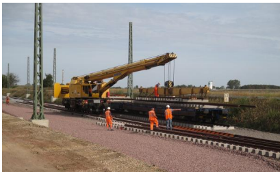
Am Südkopf des Bahnhofs Köthen werden neue Weichen verlegt (Stand: August 2019) [Quelle: DB Netz AG]
