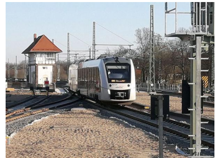
Die erste Regionalbahn 50 (RB 50) verlässt den Bahnhof Köthen Richtung Dessau nach der Inbetriebnahme der Elektronischen Stellwerke (ESTW) in Köthen und in Stumsdorf (April 2020) [Quelle: DB Netz AG]
