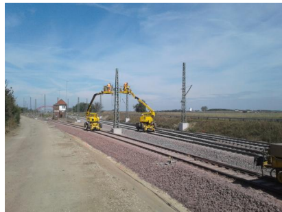
Die Montage der neuen Oberleitung am Südkopf des Bahnhofs Köthen wird vorbereitet (Stand: September 2019) [Quelle: DB Netz AG]
