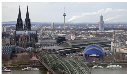
Die Schieneninfrastruktur im Eisenbahnknoten Köln wird umfassend ausgebaut [Quelle: Deutsche Bahn AG/Axel Hartmann]
