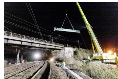
Im Eisenbahnknoten Köln werden neue Signalbrücken errichtet (Stand: März 2021) [Quelle: Nahverkehr Rheinland NVR/Smilla Dankert]
