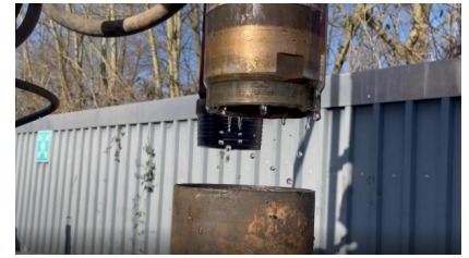
YouTube: Baugrunduntersuchungen zum Ausbau der S 11 (Juli 2022) [Quelle: DB Netz AG]
