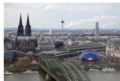
Die Schieneninfrastruktur im Eisenbahnknoten Köln wird umfassend ausgebaut [Quelle: Deutsche Bahn AG/Axel Hartmann]
