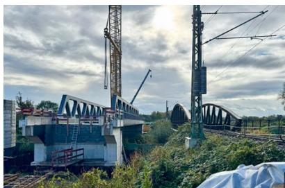
Der neue Überbau wurde in Parallellage zur alten Brücke eingehoben (Oktober 2024) [Quelle: DB InfraGO AG]
