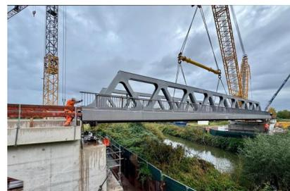
Der neue Überbau wird eingehoben (Oktober 2024) [Quelle: DB InfraGO AG]
