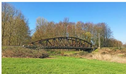
Die eingleisige Eisenbahnüberführung hat das Ende ihrer technischen Nutzungsdauer erreicht und wird deshalb durch einen Neubau ersetzt (März 2019)
