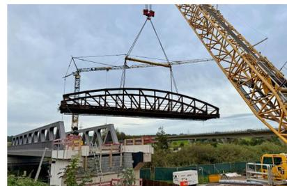
Die aus dem Jahr 1904 stammende Stahlfachwerkbogenbrücke wird ausgehoben (Oktober 2024) [Quelle: DB InfraGO AG]
