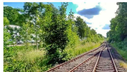
An der Strecke entsteht in Schwentinental der neue Haltepunkt „Gutenbergstraße“ (Dezember 2022) [Quelle: DB Netz AG]
