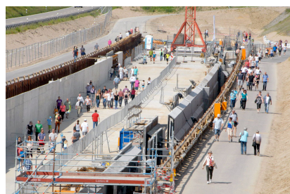
Zahlreiche Besucher informierten sich am Tag der offenen Baustelle (26. Mai 2015) am Tunnel Rastatt über das Projekt [Quelle: Erhard Hehl]
