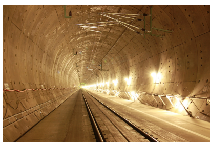
Wie in diesem Beispiel soll sich auch die zukünftige Rastatt-Tunnelröhre aus zahlreichen jeweils zwei Meter langen Tübbingringen zusammensetzen [Quelle: Deutsche Bahn AG]
