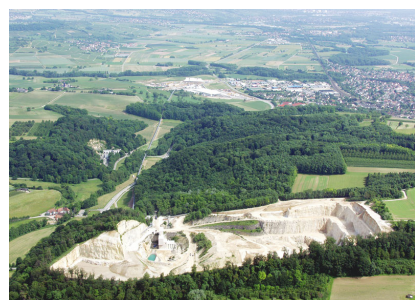
Für den Neubau des Katzenbergtunnels wurden abgetragene Gesteinsmassen direkt in den Steinbruch „Kapf“ befördert [Quelle: Deutsche Bahn AG]
