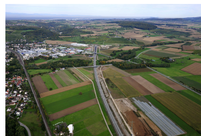
Luftaufnahme der Trasse, die ins Südportal des Katzenbergtunnels mündet [Quelle: Deutsche Bahn AG]
