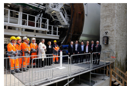
Der offizielle Baubeginn am Tunnel Rastatt fand am 25. Mai 2016 statt [Quelle: Erhard Hehl]
