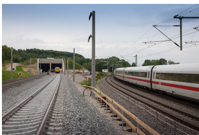
Neben dem fertiggestellten Nordportal des Katzenbergtunnels verläuft die bestehende Rheintalbahn [Quelle: Deutsche Bahn AG]
