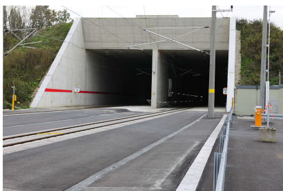
Das Südportal des Katzenbergtunnels [Quelle: Deutsche Bahn AG]
