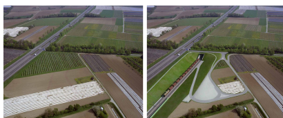
links: Westlich von Mengen entsteht das Südportal des Mengener Tunnels, rechts: Visualisierung des Mengener Tunnels, der nach 1.956 Metern an dieser Stelle wieder ans Tageslicht kommt [Quelle: Deutsche Bahn AG]
