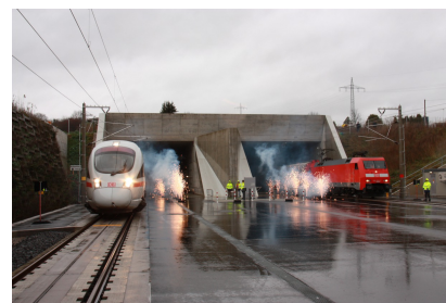
Der Katzenbergtunnel, Deutschlands drittgrößter Bahntunnel, wurde im Dezember 2012 in Betrieb genommen [Quelle: Deutsche Bahn AG]
