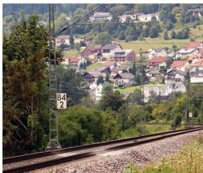
Der Abschnitt Horb am Neckar – Neckarhausen wird zweigleisig ausgebaut (November 2020) [Quelle: DB Netz AG]
