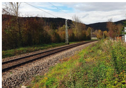
Der Abschnitt Horb am Neckar – Neckarhausen wird zweigleisig ausgebaut (November 2020) [Quelle: DB Netz AG]
