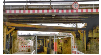
Trotz der Verzögerungen bleibt der Durchgang unter der Brücke für die Fußgänger:innen und Radfahrer:innen gewährleistet (Februar 2022) [Quelle: DB Engineering & Consulting]
