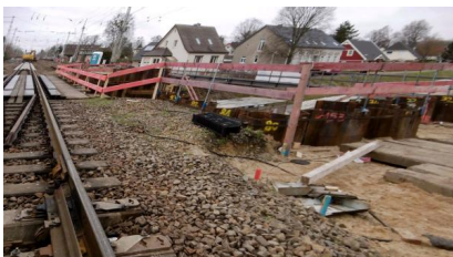
Aufgrund von notwendigen Anpassungen im Bauablauf werden die weiteren Arbeiten verändert ausgeführt (Februar 2022) [Quelle: DB Engineering & Consulting]
