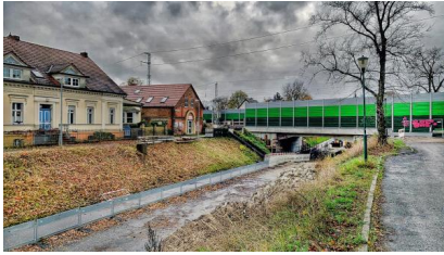
Blick auf die nahezu fertiggestellte Eisenbahnüberführung (November 2023) [Quelle: DB Netz AG]
