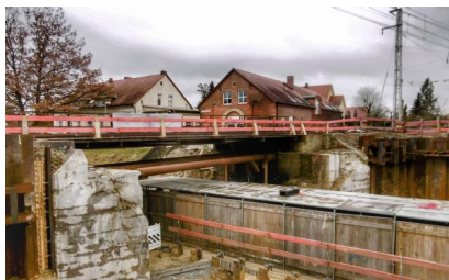
Aufgrund von notwendigen Anpassungen im Bauablauf werden die weiteren Arbeiten verändert ausgeführt (Februar 2022) [Quelle: DB Engineering & Consulting]
