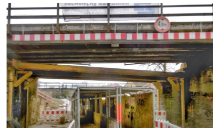
Trotz der Verzögerungen bleibt der Durchgang unter der Brücke für die Fußgänger:innen und Radfahrer:innen gewährleistet (Februar 2022) [Quelle: DB Engineering & Consulting]
