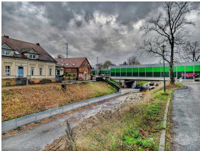
Blick auf die nahezu fertiggestellte Eisenbahnüberführung (November 2023) [Quelle: DB Netz AG]
