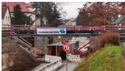
Trotz der Verzögerungen bleibt der Durchgang unter der Brücke für die Fußgänger:innen und Radfahrer:innen gewährleistet (Januar 2022) [Quelle: DB Engineering & Consulting]
