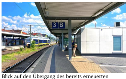
Blick auf den Übergang des bereits erneuerten Bahnsteigs 2/14 zum noch zu erneuernden Bahnsteig 3/15 (August 2022) [Quelle: DB Station&Service AG/Sebastian Bechstedt]
