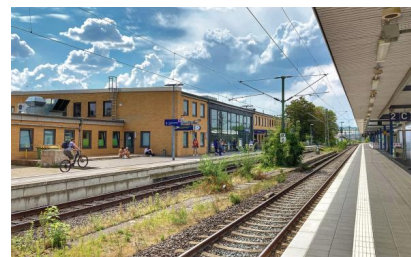
Erneuerter Bahnsteig an Gleis 2 mit Blick auf das Empfangsgebäude (August 2022) [Quelle: DB Station&Service AG/Sebastian Bechstedt]
