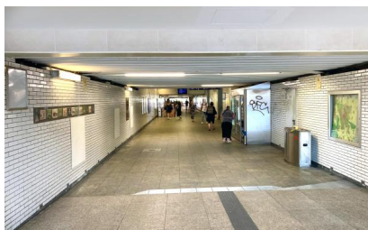
Die Personenunterführung vor der Modernisierung (August 2022) [Quelle: DB Station&Service AG/Sebastian Bechstedt]
