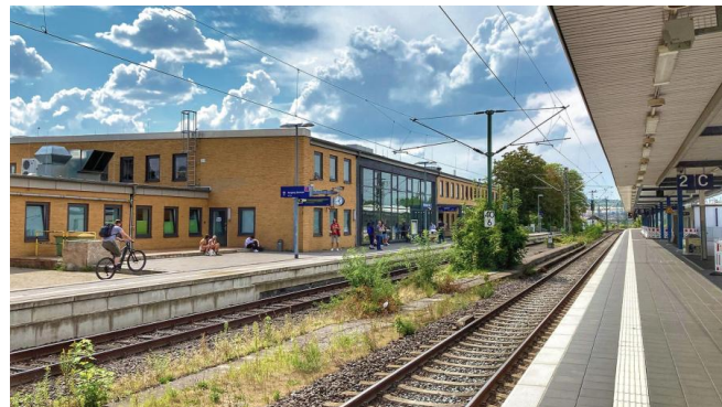
Erneuerter Bahnsteig an Gleis 2 mit Blick auf das Empfangsgebäude (August 2022) [Quelle: DB Station&Service AG/Sebastian Bechstedt]
