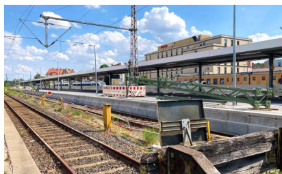
Blick auf den erneuerten Bahnsteig 2/14 sowie auf die neuen Oberleitungsmaste und den zu ersetzenden Prellbock im Vordergrund (August 2022) [Quelle: DB Station&Service AG/Sebastian Bechstedt]
