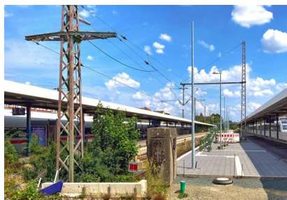
Blick auf den erneuerten Bahnsteig 2/14 sowie auf die noch zu erneuernden Gleisabschlüsse. Hier steht zudem künftig der neue Aufenthaltspavillon (August 2022) [Quelle: DB Station&Service AG/Sebastian Bechstedt]
