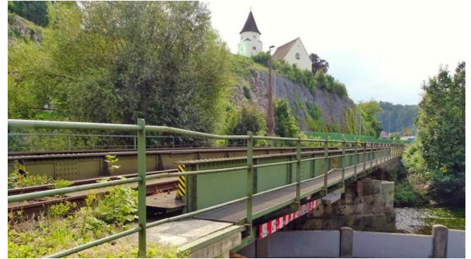
Die neue, möglichst durchlässige Bogenbrücke ohne Mittelpfeiler wird sich harmonisch ins Stadtbild zwischen dem Schloss Hellenstein und dem Totenberg, den beiden Wahrzeichen der Stadt, einfügen (August 2019) [Quelle: DB Netz AG/Kevin Adler]
