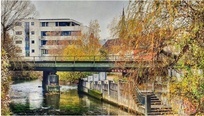
Die Eisenbahnbrücke über die Brenz am südlichen Ende des Bahnhofs Heidenheim hat das Ende ihrer technischen Nutzungsdauer erreicht und wird von uns durch einen Neubau ersetzt (August 2019) [Quelle: DB Netz AG/Kevin Adler]
